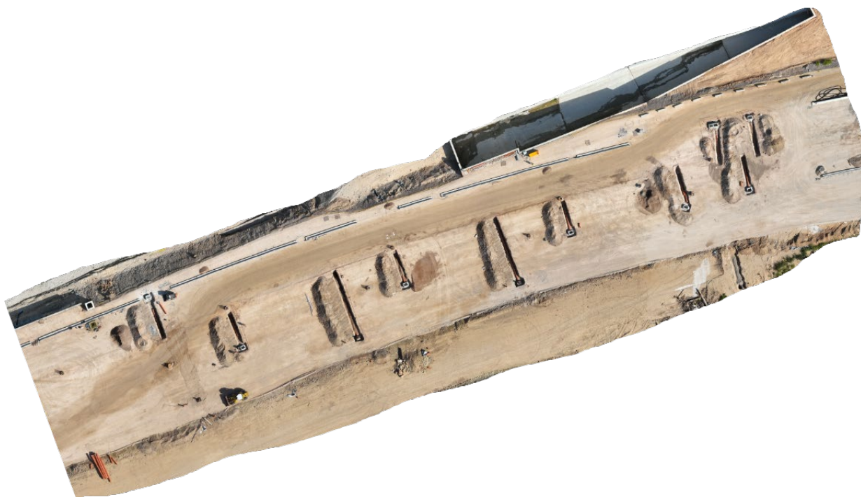
Εικόνα 26 - 10/04/2025 - Κατασκευή επιφανειακής αποστράγγισης οδού και τοποθέτηση πλαϊνών κρασπέδων (συνέχεια)
