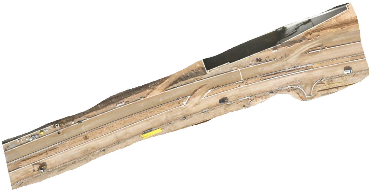
Εικόνα 35 - 24/10/2025 – Περαιτέρω διαμόρφωση κεντρικής νησίδας με τοποθέτηση κρασπέδων και πλήρωσης με χώμα
