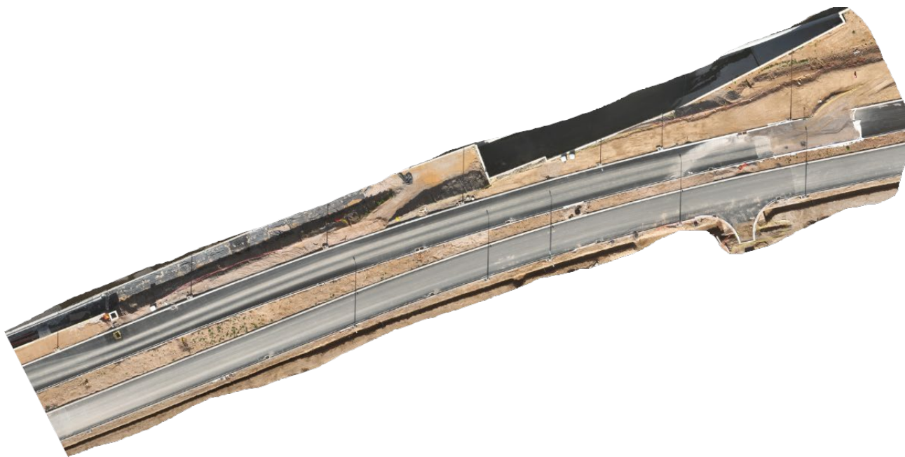
Εικόνα 39 - 30/01/2026 – Τοποθέτηση ιστών οδοφωτισμού στο κάτω τμήμα της οδού
