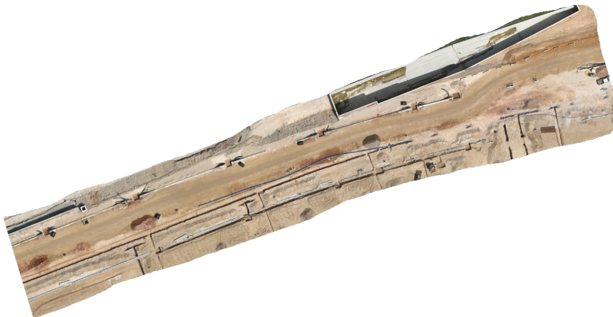
Εικόνα 29 - 15/05/2025 – Δημιουργία σκάμματος και εγκατάσταση 2 ου (μοβ) αγωγού ΕΥΔΑΠ
