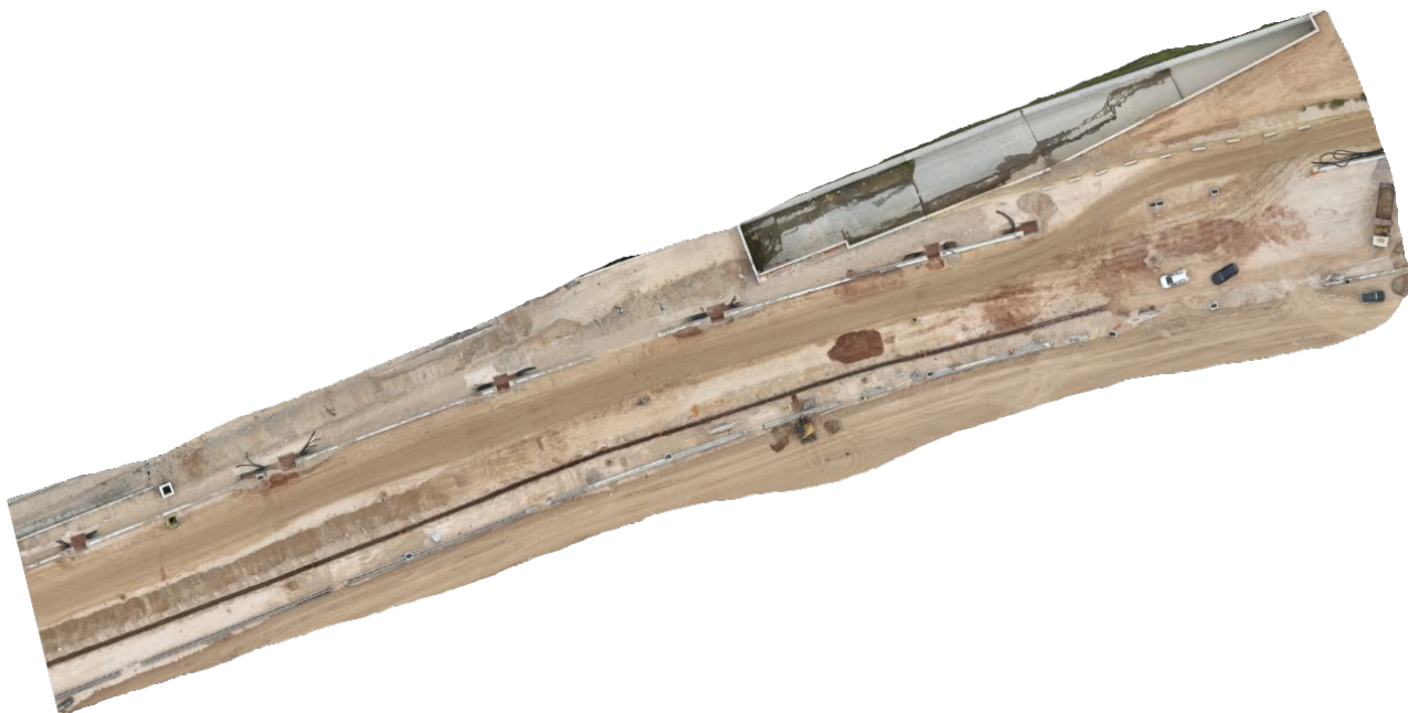
Εικόνα 28 - 05/05/2025 – Δημιουργία σκάμματος και εγκατάσταση 1ου αγωγού ΕΥΔΑΠ
