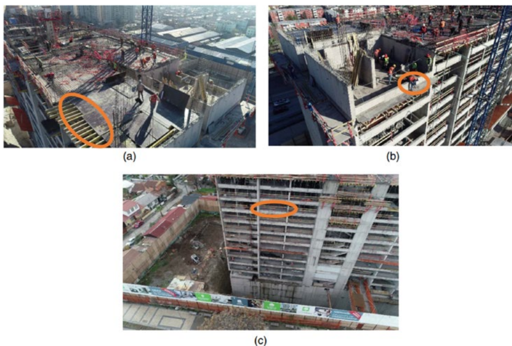
Εικόνα 14 - Εικόνες από drone σε αποστολή επίβλεψης ασφάλειας εργοταξίου στη Χιλή: (a) και (c) απουσία προστατευτικού κιγκλιδώματος, (b) εργάτης σε ύψος χωρίς τη χρήση προστατευτικού μάντα, (Choi, Kim, Kim, & Na, 2023)
