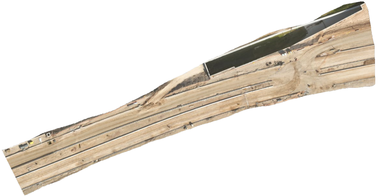
Εικόνα 34 - 26/08/2025 – Τοποθέτηση κρασπέδων κεντρικής νησίδας
