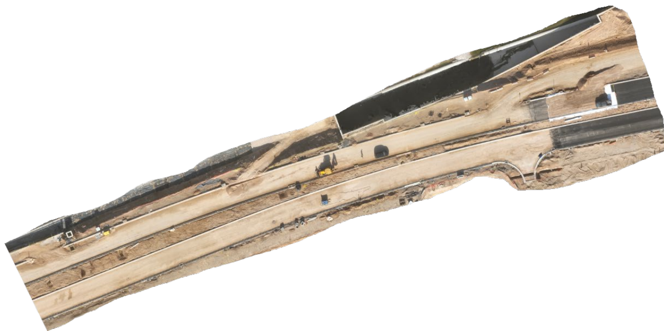
Εικόνα 36 - 20/11/2025 – Έναρξη οδοστρώσας οδού
