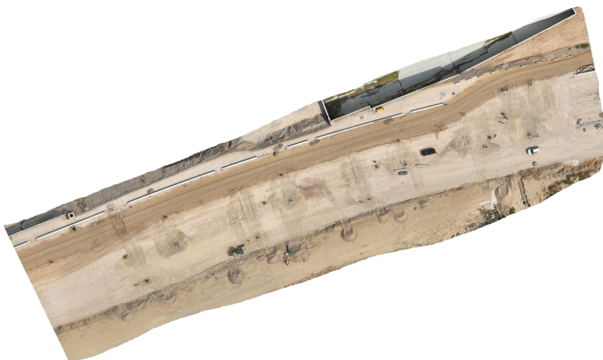
Εικόνα 27 - 24/04/2025 – Επιχώσεις σκαμμάτων επιφανειακής αποστράγγισης
