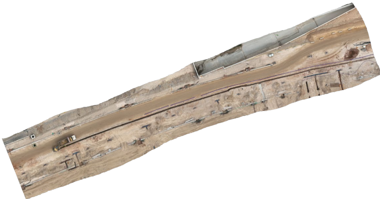
Εικόνα 30 - 22/05/2025 – Δημιουργία σκάμματος και εγκατάσταση 3 ου (μοβ) αγωγού ΕΥΔΑΠ, εκσκαφές για τοποθέτηση βάσεων ιστών οδοφωτισμού
