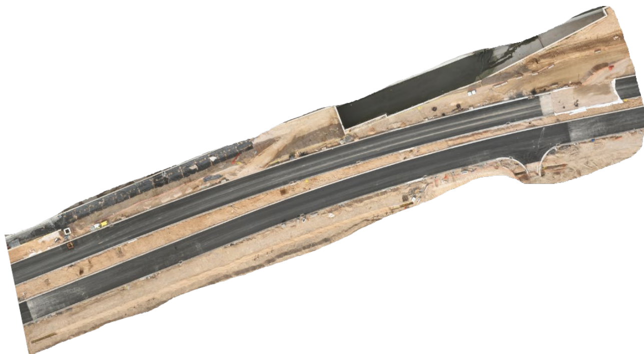
Εικόνα 37 - 27/11/2025 – Συνέχιση οδοστρώσας οδού
