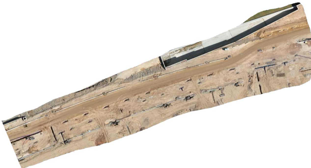
Εικόνα 31 - 29/05/2025 – Τοποθέτηση βάσεων ιστών οδοφωτισμού
