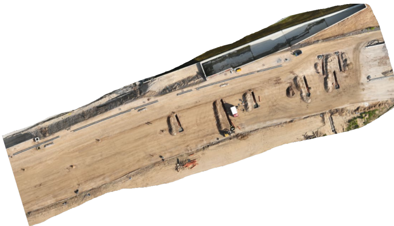
Εικόνα 25 - 04/04/2025 – Κατασκευή επιφανειακής αποστράγγισης οδού και τοποθέτηση πλαϊνών κρασπέδων
