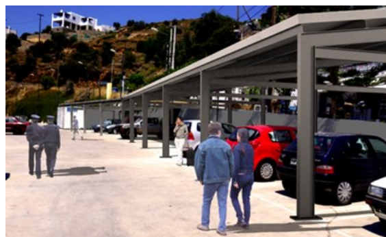
Εικόνα 4.8. Φωτοβολταϊκό στέγαστρο στη Σκύρο (Πηγή : Δ.Λ.Τ Σκύρου)
