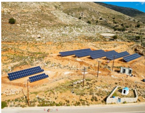
Εικόνα 4.2 Φωτοβολταϊκό πάρκο Τήλου (Πηγή : https://eunice-group.com/gr/projects )
