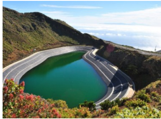
Εικόνα 2.3 Υδροηλεκτρικός σταθμός (Πηγή: https://ec.europa.eu/ )
