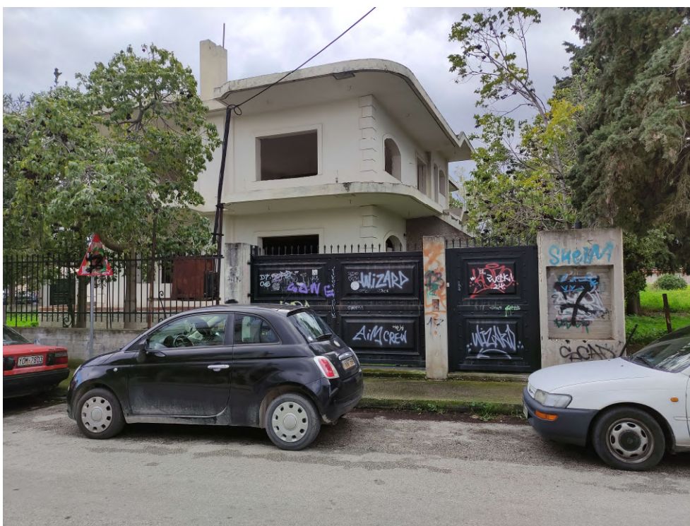
Εικόνα 6 - Βόρεια όψη του κτιρίου (επi της οδού Χρυσοστόμου Σμύρνης)
