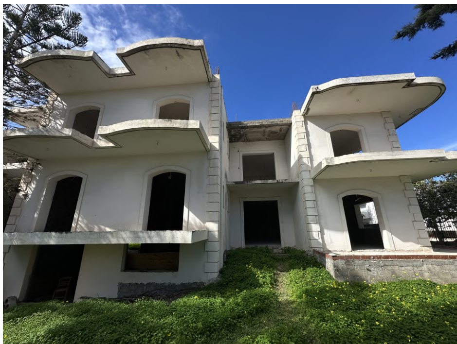
Εικόνα 9 - Ανατολική όψη όπου φαίνεται ολόκληρο το κτίριο
