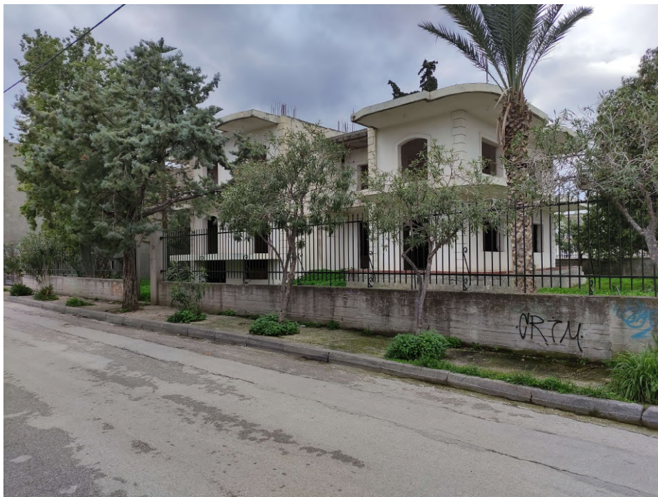
Εικόνα 5 - Ανατολική όψη του κτιρίου (επi της οδού Παπανικολή)
