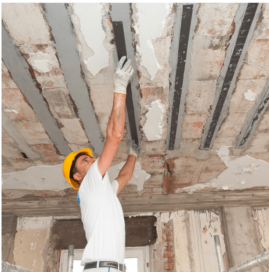
Εικόνα 72 - Τοποθέτηση ανθρακοελασμάτων
