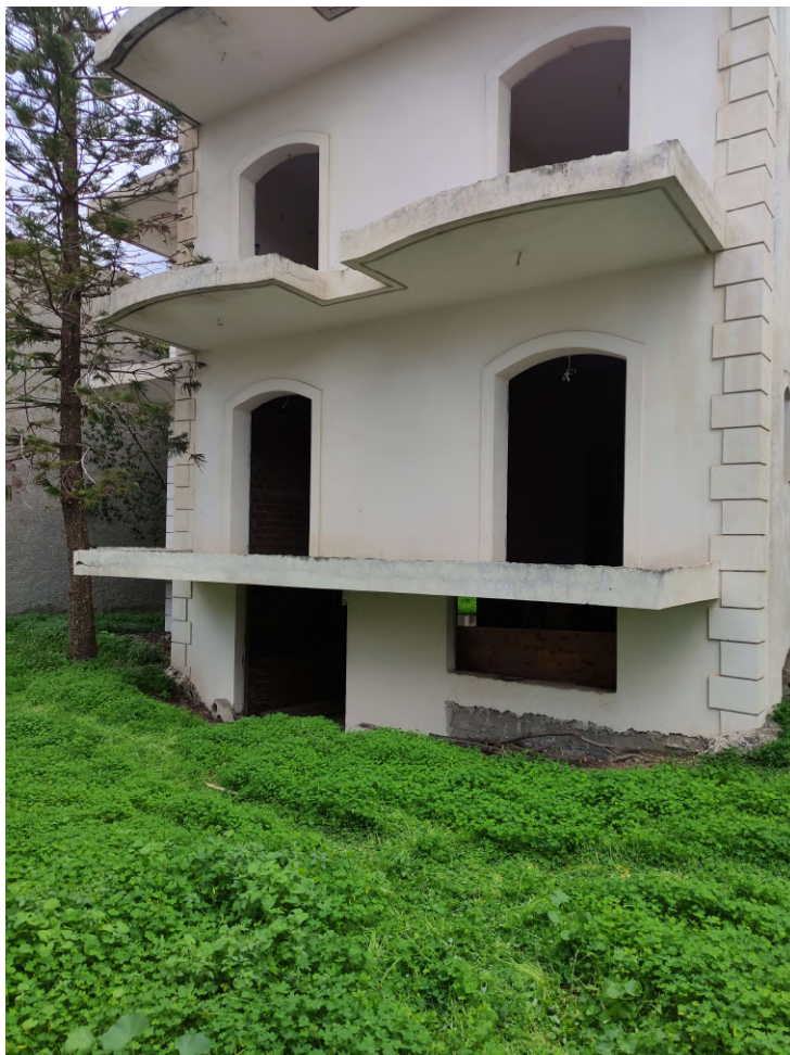
Εικόνα 8 - Ανατολική όψη - το τμήμα του κτιρίου που βρίσκεται σε υψηλότερη στάθμη
