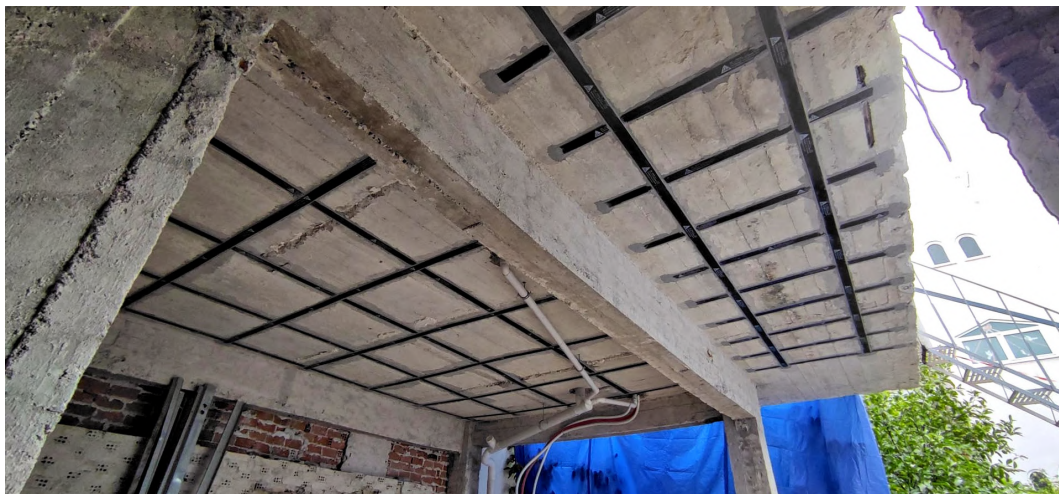
Εικόνα 71 - Παράδειγμα ενίσχυσης πλακών με ανθρακοελάσματα
