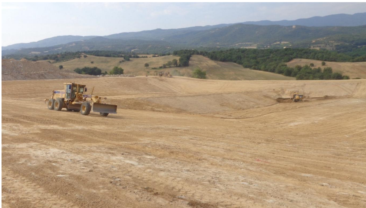
Εικόνα 12. Προετοιμασία υπεδάφους πριν από τη διάστρωση της αργιλικής στρώσης.
