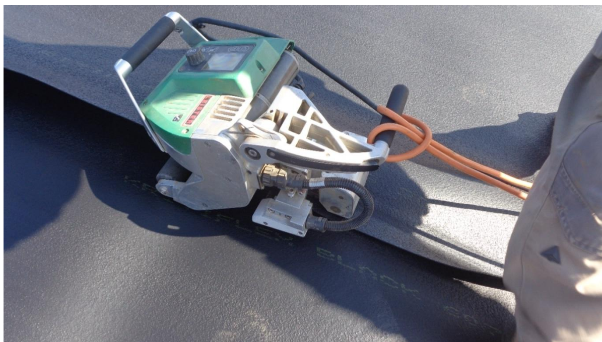
Εικόνα 14. Συγκόλληση γεωμεμβράνης με χρήση συσκευής διπλής ραφής Leister GEOSTAR G5.
