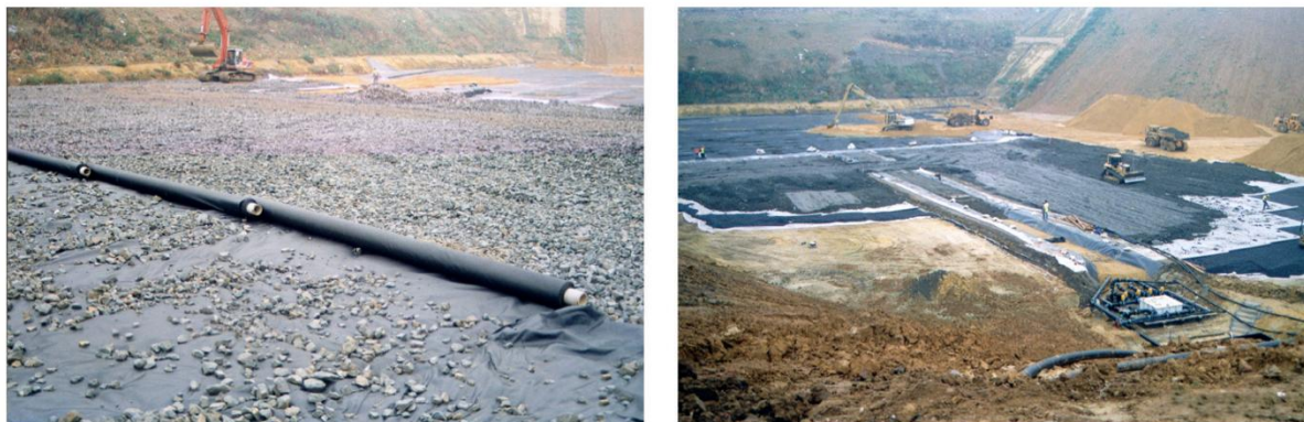
Εικόνα 10. Γενική άποψη των βασικών στρώσεων κατά την τοποθέτηση γεωφασμάτων Terralys (Πηγή: Meerleer et al., 2000).
