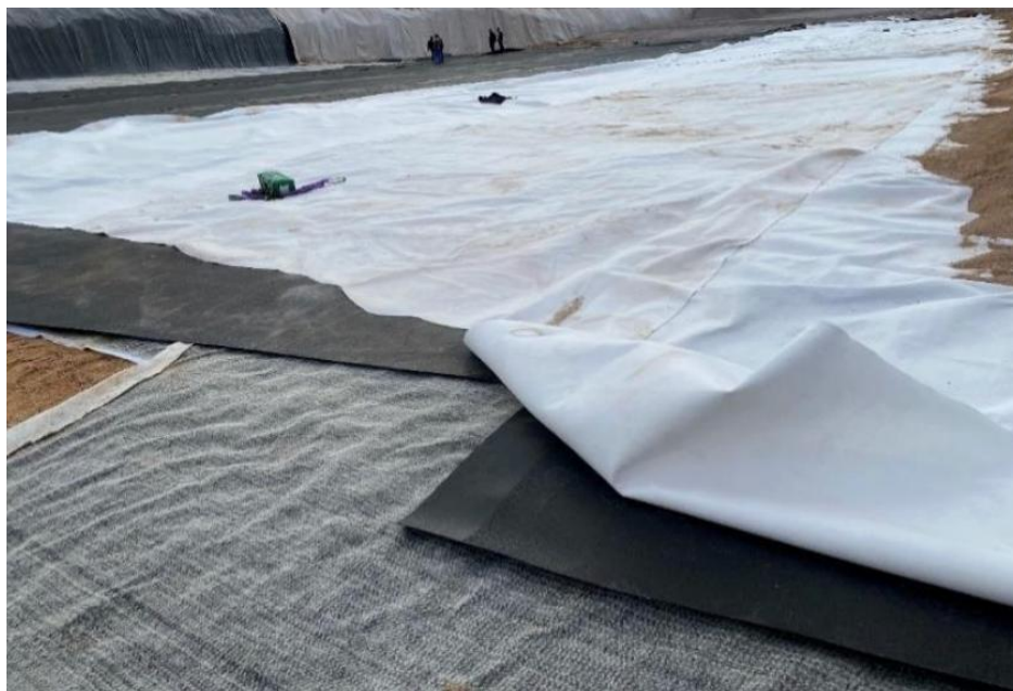
Εικόνα 3. Αργιλικός και γεωσυνθετικός φραγμός – φύλλα μπετονίτη – γεωμεμβράνη – γεωφάσμα προστασίας μεμβράνης (Πηγή: Κόλλιας, 2004).
