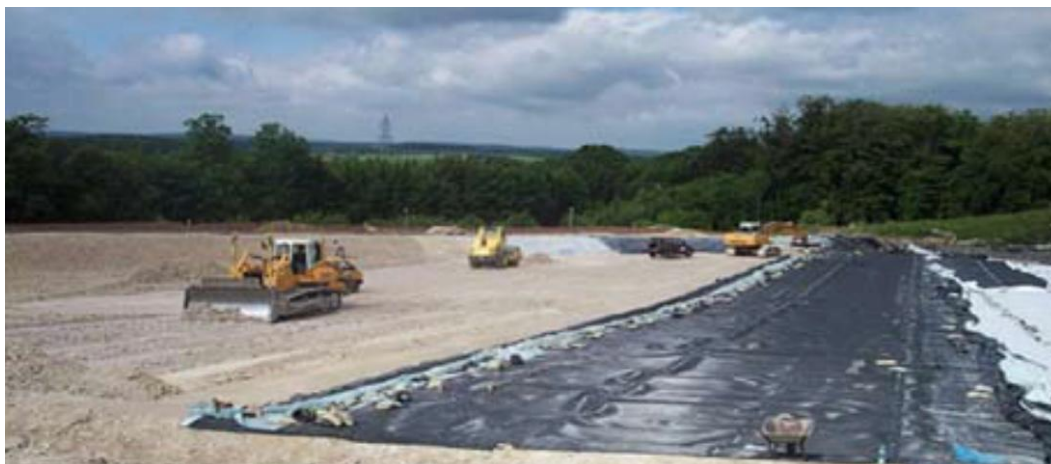
Εικόνα 8. Τοποθέτηση της αργλικής στρώσης (Πηγή: National Solid Waste Management Commission (NSWMC) & Japan International Cooperation Agency (JICA), 2010 ).
