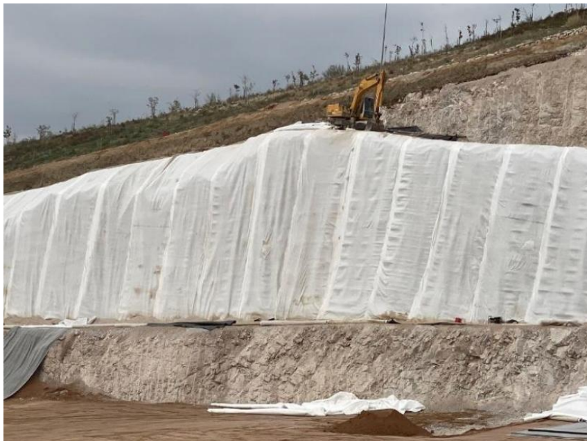
Εικόνα 4. Γεωσυνθετική αποστραγγιστική στρώση κατακόρυφων πρανών (Πηγή: Φουντούλης & Ανδρεαδάκης, 2009).
