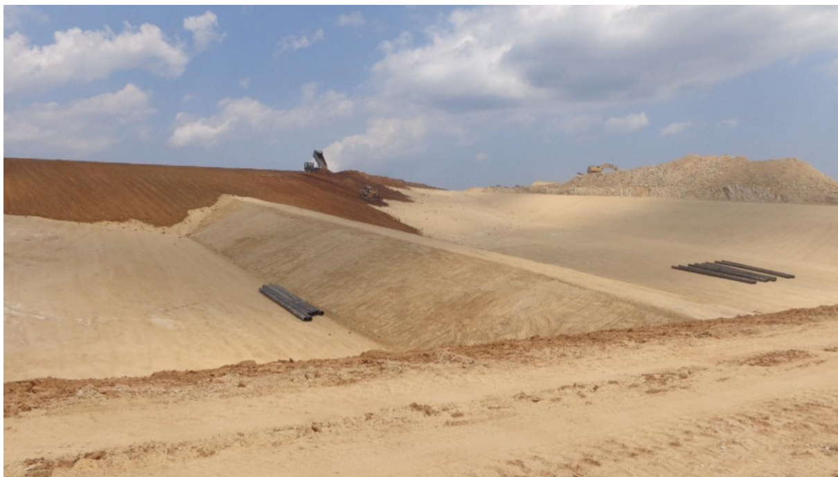
Εικόνα 13. Διάστρωση της αργιλικής στρώσης.
