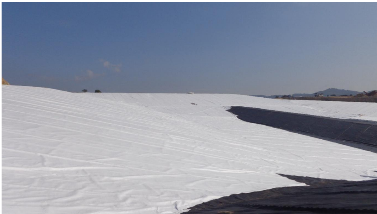
Εικόνα 15. Τοποθέτηση γεωφάσματος.
