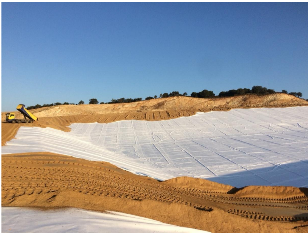
Εικόνα 16. Διάστρωση άμμου προστασίας.
