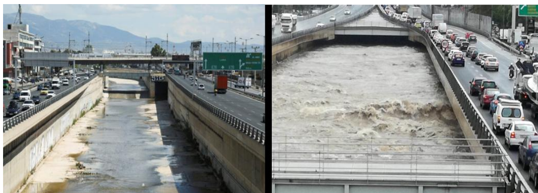
Εικόνα 22. Ο ποταμός Κηφισός στην Αττική, με βασική ροή (αριστερή) και στο όριο της υπερχειλίσης (δεξιά) μετά από επεισόδιο έντονης βροχόπτωσης.
