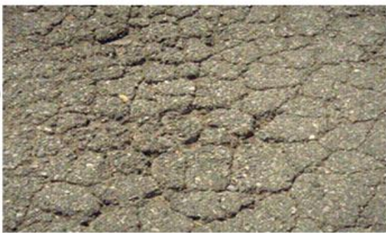
Εικόνα 4 Υψηλής έντασης ρωγμές τύπου αλιγάτορα
