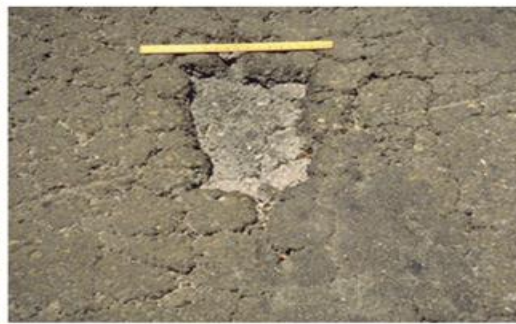
Εικόνα 4 Υψηλής έντασης ρωγμές τύπου αλιγάτορα
