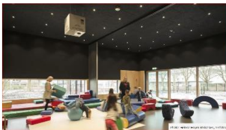
Εικόνα 45. Ενδεικτική εφαρμογή ακουστικών πάνελ ξυλόμαλλου σε παιδικό σταθμό. Παράδειγμα από το Børnehuset Himmel & Hav στη Δανία. Πηγή: Troldekt, φωτογραφία: Helene Høyer Mikkelsen.
