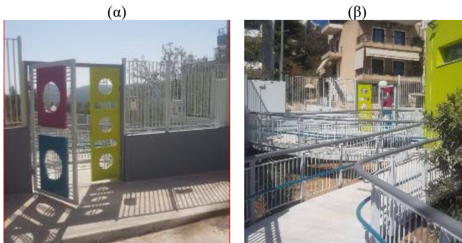
Εικόνα 9. (α) Εξωτερική Αυλόθυρα Εισόδου/ Εξόδου του ΒΝΣ Χαϊδαρίου. (β) Άποψη της Πρόσβασης προς την Αυλόθυρα μέσω της Ράμπας
