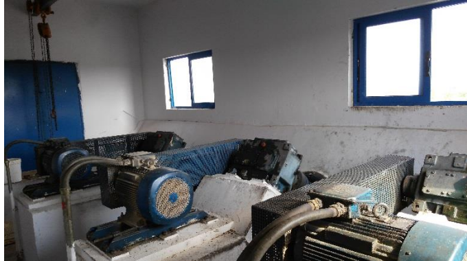
Εικόνα 6 : Χώρος Κοχλιών Αρχιμήδη (Δ.Ε.Υ.Α.Σ, 2023)
