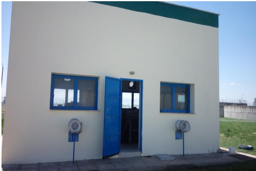
Εικόνα 15: Κτίριο Χημικής Αποφωσφόρωσης ( Δ.Ε.Υ.Α.Σ. ,2023)
