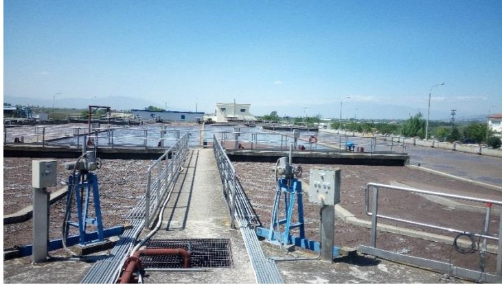
Εικόνα 11: Δεξαμενές Αερισμού (Δ.Ε.Υ.Α.Σ. ,2023 )
