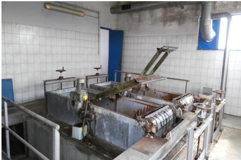
Εικόνα 7: Μονάδα Ψιλοεσχάρωσης ( Δ.Ε.Υ.Α.Σ ,2023 )
