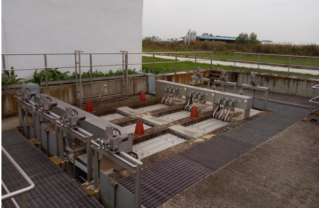
Εικόνα 17: Μονάδα Απολύμανσης με Υπεριώδη Ακτινοβολία ( Δ.Ε.Υ.Α.Σ., 2023 )
