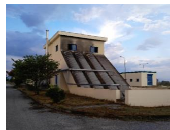
Εικόνα 5: Μονάδα Προεπεξεργασίας ( Δ.Ε.Υ.Α.Σ., 2023 )
