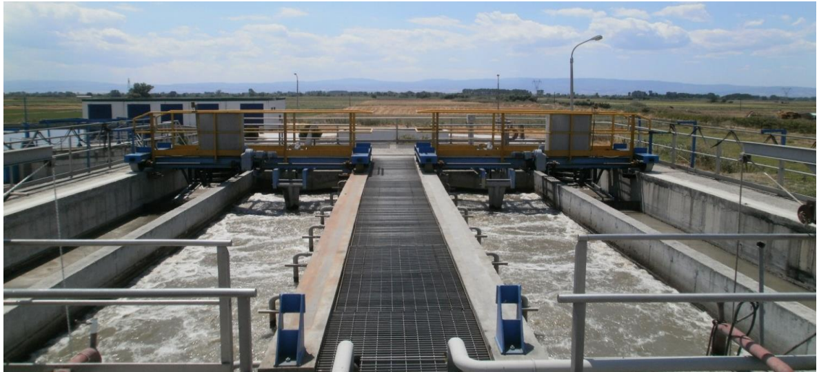
Εικόνα 8: Γέφυρες Μονάδας Εξάμωσης ( Δ.Ε.Υ.Α.Σ., 2023 )
