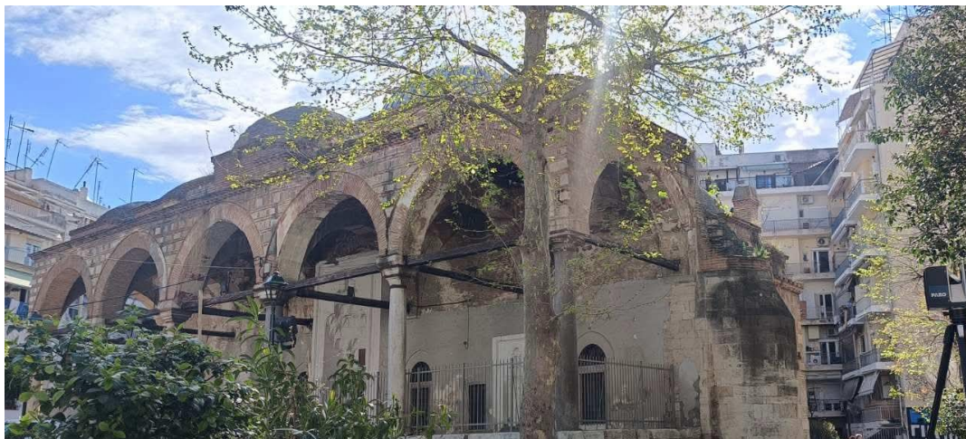
Εικόνα 12: Ενδεικτική θέση TLS
