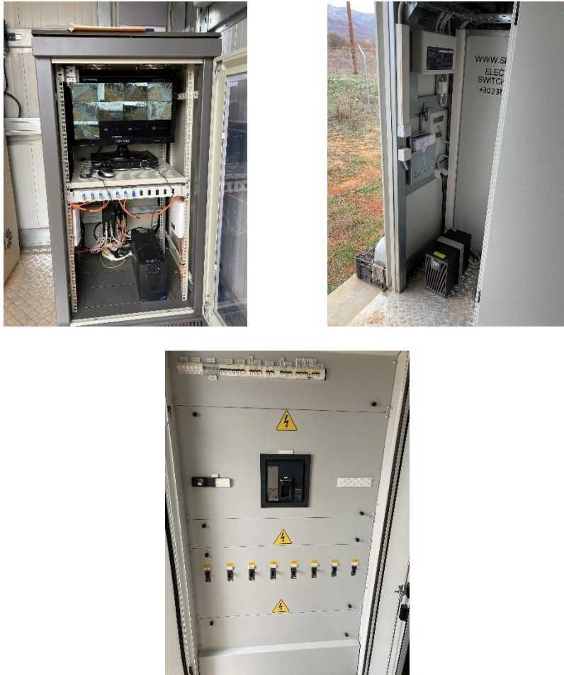
Εικόνα 11. Ενδεικτικές φωτογραφίες πίνακα XT φωτοβολταϊκού σταθμού και πινάκων συστημάτων ασφάλειας
