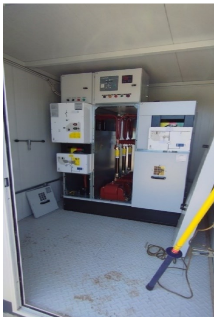
Εικόνα 15. Γενικός πίνακας Μέσης Τάσης
