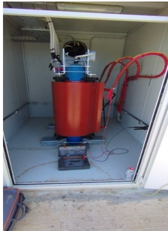
Εικόνα 12. Ενδεικτικές φωτογραφίες μετασχηματιστή ξηρού τύπου και ελαίου
