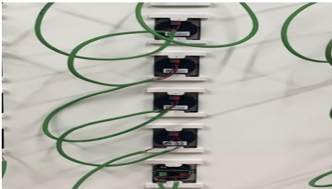
Εικόνα 26 Διακόπτες KNX παράλληλη σύνδεση καλωδίου. Πηγή https://www.youtube.com/shorts/HCdMb1DJ_ZY
