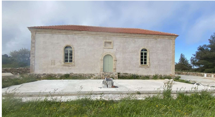
Εικόνα 3.22: Νότια όψη του Αστικού Σχολείου Ποταμού μετά την ολοκλήρωση των εργασιών αποκατάστασης
