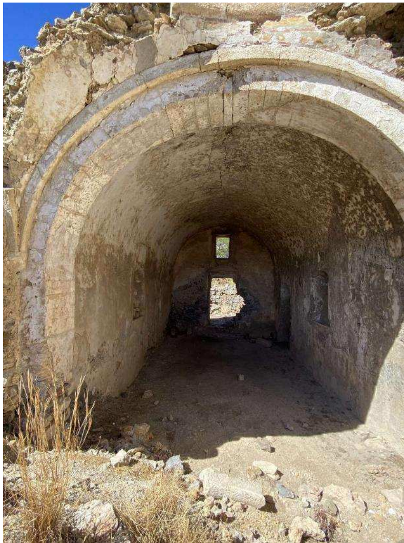
Εικόνα Α4.8: Εσωτερικό.
