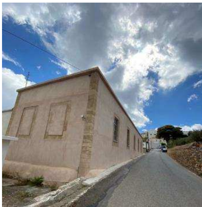
Εικόνα Α1.4: Η πίσω και πλάγια όψη, όπου διακρίνονται δύο χτισμένα παράθυρα από μεταγενέστερες επεμβάσεις— κλειστά ήδη από τη δεκαετία του 1940. Φωτογραφία και ψηφιακή επεξεργασία: η συγγραφέας.
