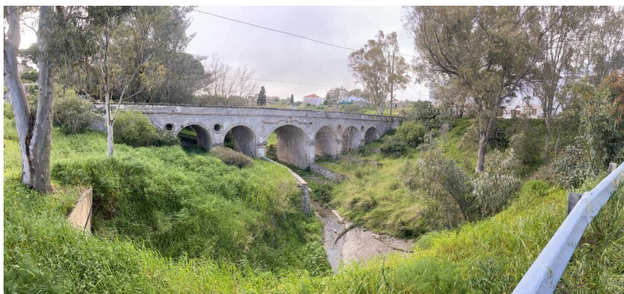
Εικόνα 2.11: Η επτάτοξη λιθόκτιστη γέφυρα του Ποταμού, Κύθηρα.
