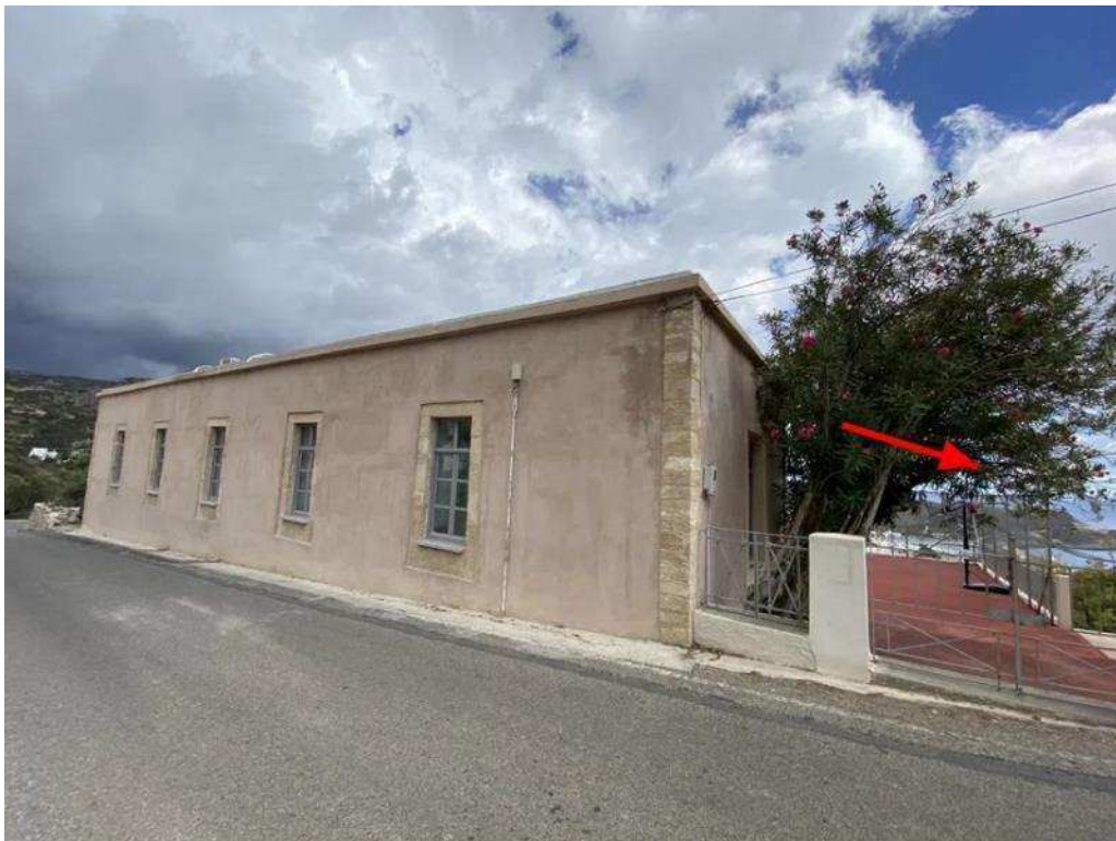
Εικόνα Α1.3: Η πίσω πλευρά του Δημοτικού Σχολείου στον δρόμο Χώρας–Καψαλίου. Από το σημείο αυτό πραγματοποιείται η πρόσβαση των μαθητών. Φωτογραφία και ψηφιακή επεξεργασία: η συγγραφέας.
