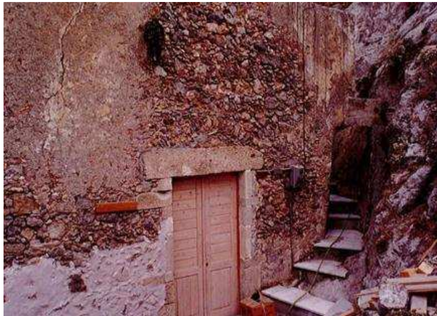
Εικόνα Α3.3: Η είσοδος πριν την αποκατάσταση — πελεκητό ανώφλι, λιθοόδημος τοίχος και σκάλα στον βράχο.
