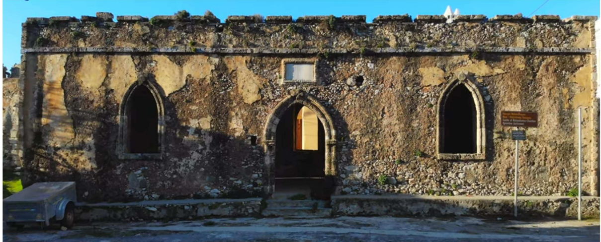
Εικόνα 3.12: Σχολείο Κάτω Χώρας Μυλοποτάμου.
