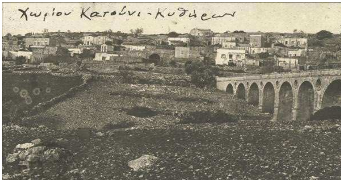
Εικόνα 5.1: Καρτ-ποστάλ της Γέφυρας Κατούνι, 1926, εκατό χρόνια μετά την κατασκευή της. Στο βάθος ο οικισμός Κατούνι. Δημιουργός: Π. Φατσέας. Πηγή: Ίδρυμα Αικατερίνης Λασκαρίδη, Ψηφιακή Συλλογή ΕΛΙΑ, κωδικός CP.CRATTI.228.
