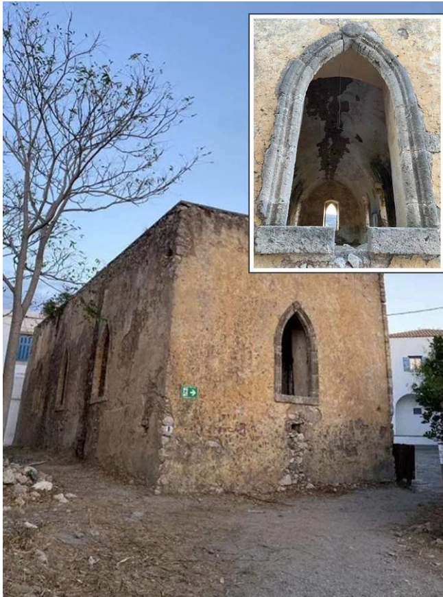
Εικόνα 3.16: Σχολείο Κάτω Χώρας Μυλοποτάμου.
