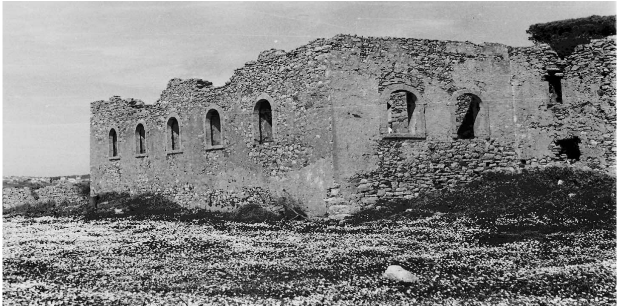
Εικόνα 3.25: Πλάγια όψη του σχολείου το 1964, σε πλήρη ερειπιακή κατάσταση.
