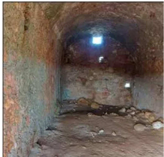
Εικόνα 3.1: Εσωτερική και εξωτερική άποψη αγροτικών οικίσκων (σπιτότοπων) με θολωτή κατασκευή (βόλτο) στο βουνό πάνω από το Διακόφτι.
