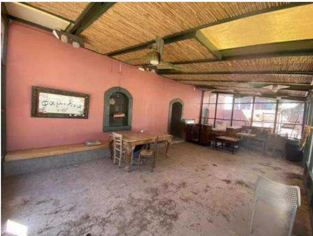
Εικόνα Α2.7: Εσωτερικό σήμερα. Καλαμένια οροφή, ροζ τοιχοποιία.
