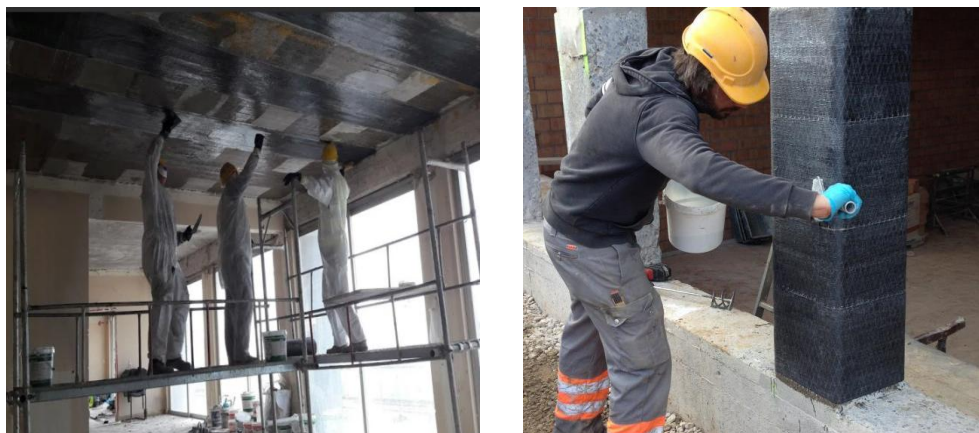
Εικόνα 7: Εφαρμογή FRP (Πηγή, sintecno Hellas ABETE)
