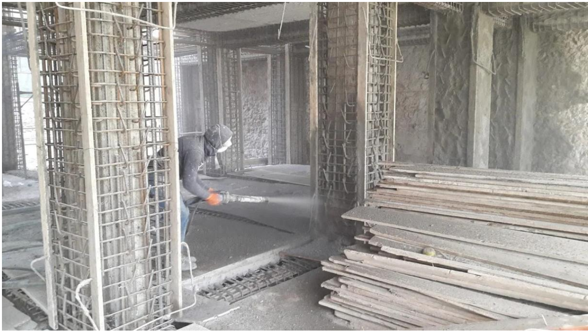
Εικόνα 5: Εφαρμογή Εκτοξευόμενου Σκυροδέματος (Πηγή, sintecno Hellas ABETE)
