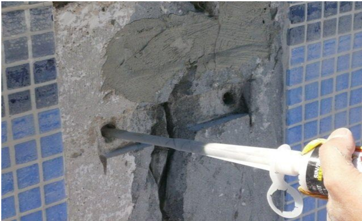
Εικόνα 2 : Αποκατάσταση ρωγμής με έγχυση εποξειδικής ρητίνης υπο πίεση (Πηγή, Παν. Πατρών, Τμήμα Πολιτικών Μηχανικών)
