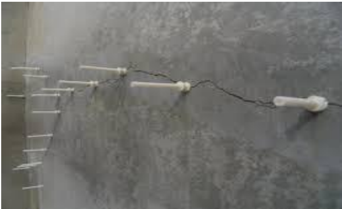
Εικόνα 3: Σφράγιση ρωγμών και τοποθέτηση ακροφύσιων (Πηγή, Παν. Πατρών, Τμήμα Πολιτικών Μηχανικών)
