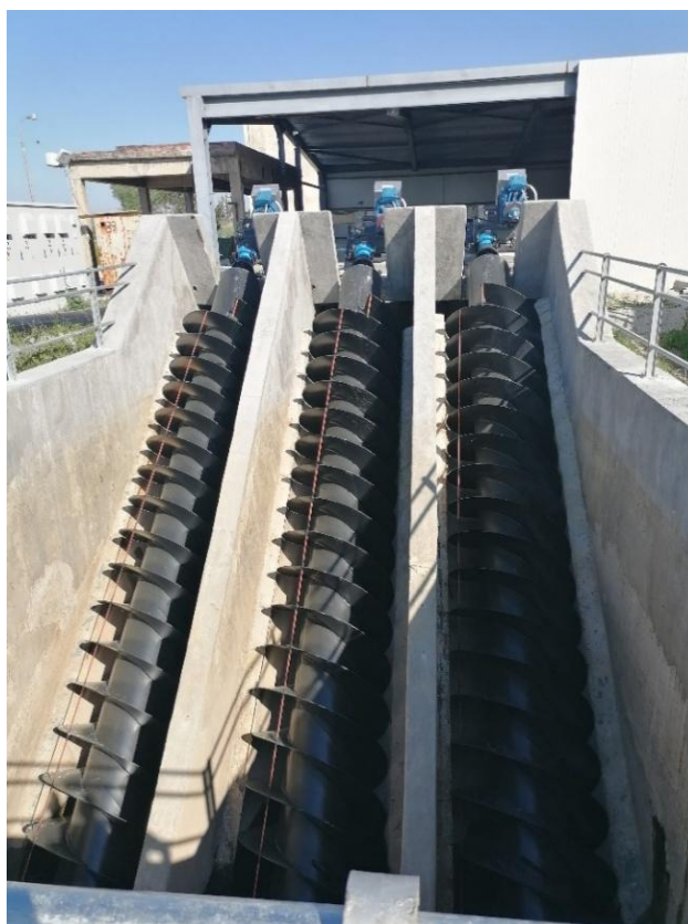
Εικόνα 4 Μεταφορά λημμάτων με χρήση κοχλία του Αρχιμήδη
