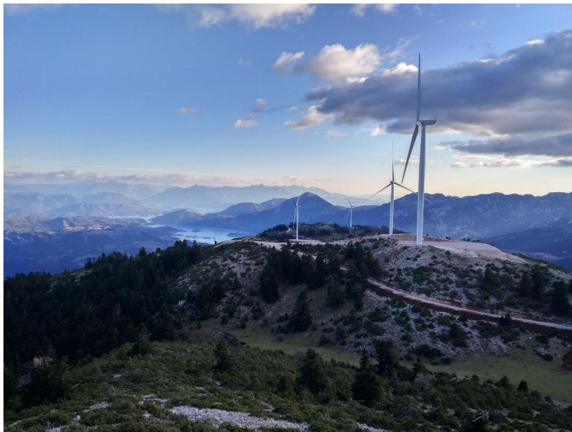
Εικόνα 1: Χερσαίο Αιολικό Πάρκο
