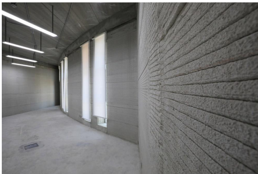
Εικόνα 53: Φωτογραφία της εξωτερικής τοιχοποιίας από το εσωτερικό του κτιρίου, στην οποία είναι εμφανείς οι στρώσεις του εκτυπωμένου υλικού
