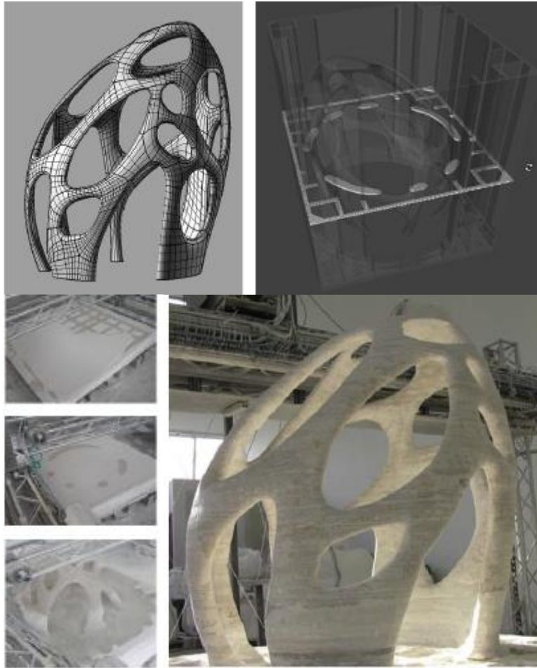
Εικόνα 21: Πάνω: το τρισδιάστατο μοντέλο της κατασκευής Radiolaria pavilion. Κάτω: τα στάδια εκτύπωσης της κατασκευής και το τελικό αντικείμενο
