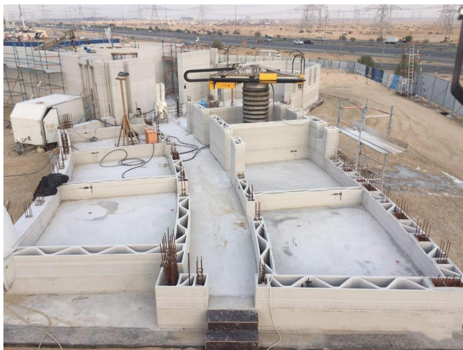
Εικόνα 51: Φωτογραφία κατά τη διάρκεια εκτύπωσης της τοιχοποιίας του κτιρίου. Εμφανή είναι επίσης τα εκτυπωμένα περιγράμματα των υποστυλωμάτων, στα οποία έχουν τοποθετηθεί οι απαιτούμενοι οπλισμοί και πρόκειται να ακολουθήσει πλήρωση με σκυρόδεμα
