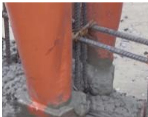
Εικόνα 28: Ενίσχυση κατασκευής 3DPC, με τοποθέτηση πλέγματος οριζόντιων και κατακόρυφων οπλισμών και εκτύπωση σκυροδέματος εκατέρωθέν τους
