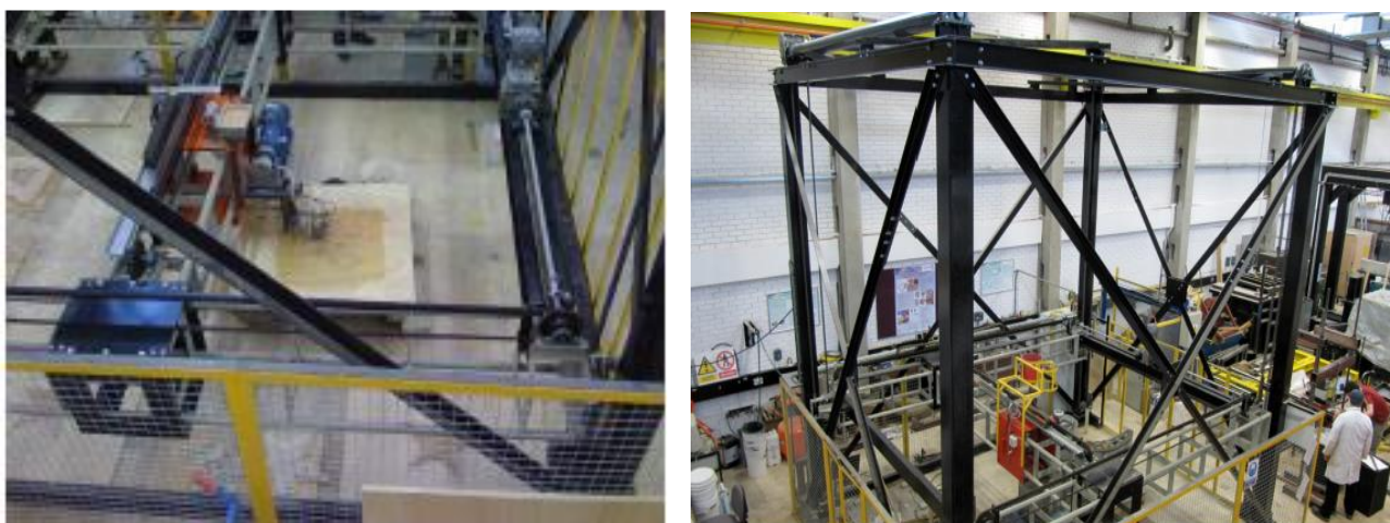
Εικόνα 16: Η διάταξη εκτύπωσης που χρησιμοποιείται στη μέθοδο Concrete Printing του Πανεπιστημίου Loughborough
