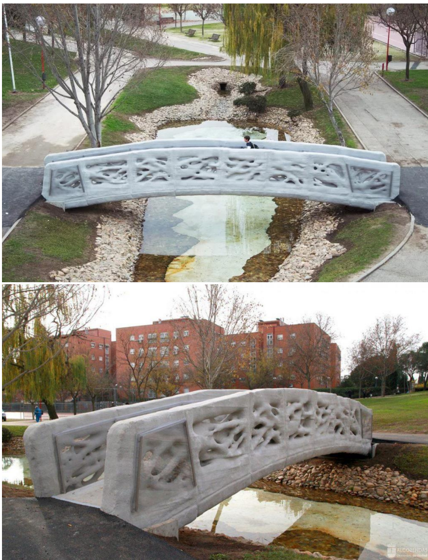
Εικόνα 22: Η πεζογέφυρα στο πάρκο της Μαδρίτης, που έχει κατασκευαστεί με τη μέθοδο D-Shape
