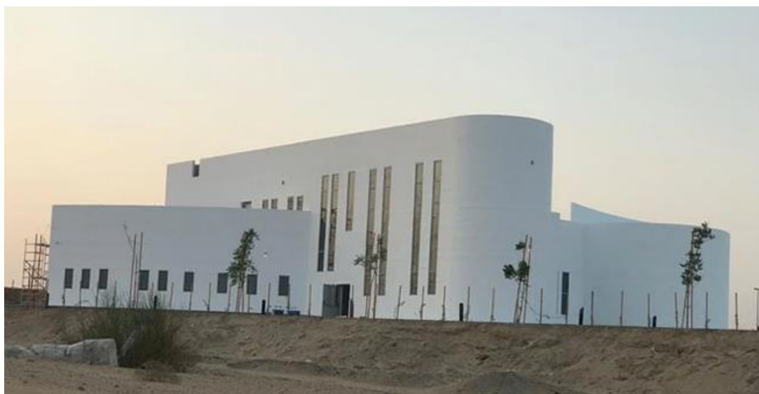
Εικόνα 49: Το διώροφο κτίριο γραφείων στο Dubai ολοκληρωμένο
