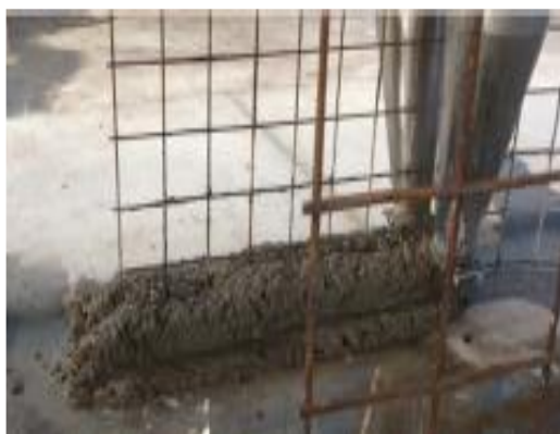
Εικόνα 28: Ενίσχυση κατασκευής 3DPC, με τοποθέτηση πλέγματος οριζόντιων και κατακόρυφων οπλισμών και εκτύπωση σκυροδέματος εκατέρωθέν τους
