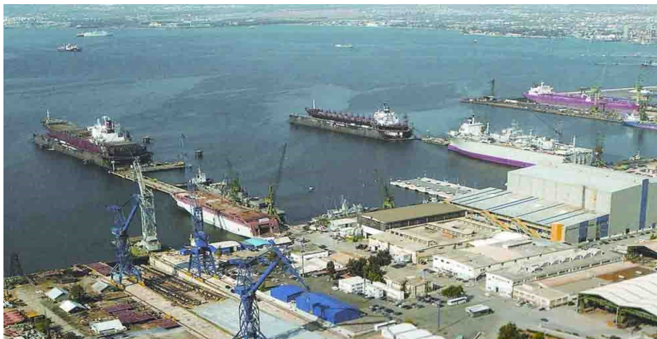
Εικόνα 4.6 : Οι εγκαταστάσεις των Ναυπηγείων Ελευσίνας. (πηγή: http://www.elefsina.gr )
