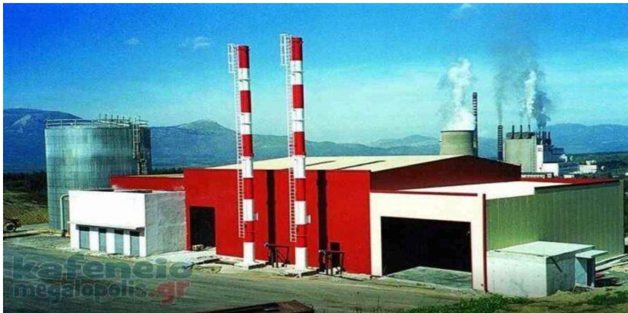
Εικόνα 12. Εγκαταστάσεις τηλεθέρμανσης στη Μεγαλόπολη.
