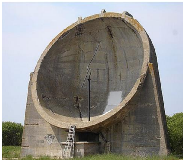
Εικόνα 2.2 Απεικόνιση συστήματος εντοπισμού ηχητικής πηγής που βασίζεται στο τοπόφωνο Mayer. ( https://uacgr.blogspot.com )
