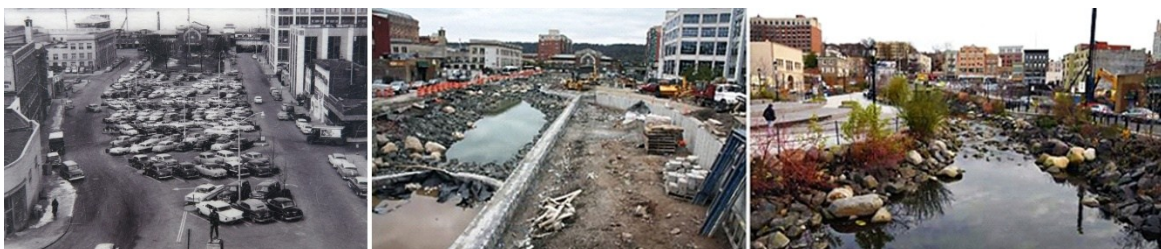
Εικόνα 38 Το έργο επαναφοράς του ποταμού Saw Mill, στο Yonkers της Νέας Υόρκης. Πρότερη κατάσταση (αριστερά), κατά τη διάρκεια της κατασκευής (κέντρο) και μετά την ολοκλήρωση (δεξιά). [Πηγές: Iowa Department of Natural Resources, https://thinkyonkers.com/news/daylighting-saw-mill-river/ ].
