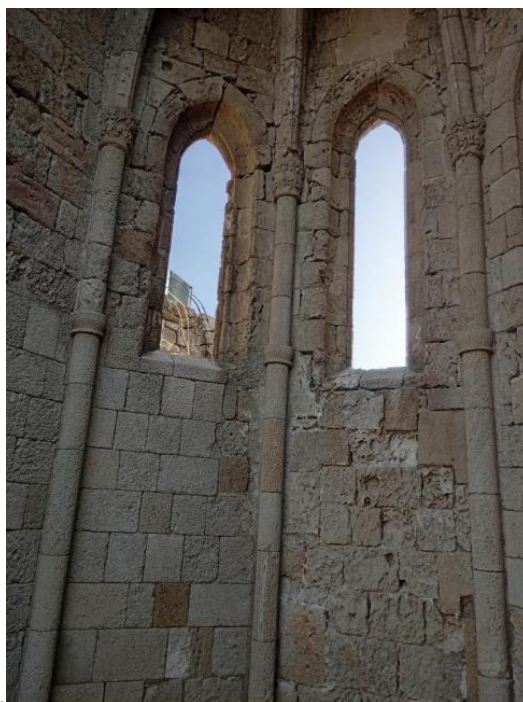
Εικόνα 9. Άποψη των οξυκόρυφων παραθύρων του νότιου τμήματος του ιερού (2026).
