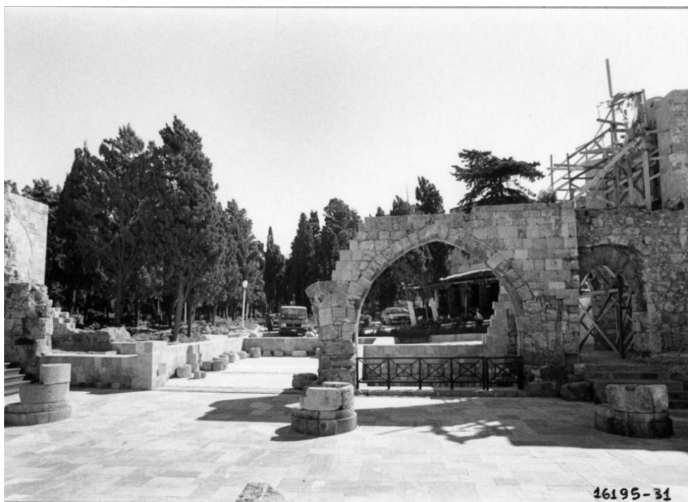
Εικόνα 30. Εσωτερική όψη νότιου κλίτους. Λήψη από Β (Φωτ. αρχείο ΥΠ ΠΟ, κωδ. 16195-31)
