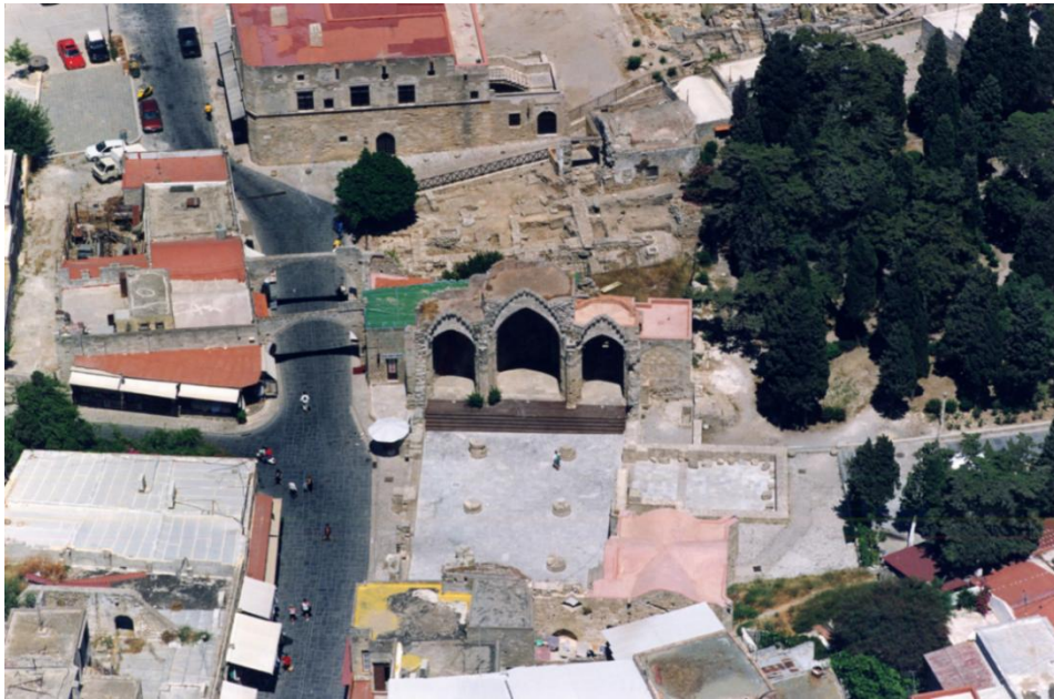
Εικόνα 2. Γενική άποψη του μνημείου μετά την αποκατάσταση. (Google earth, 2026)
