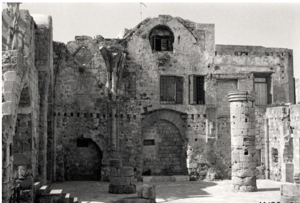
Εικόνα 8. Εσωτερική δυτική όψη. Λήψη από Α. (Φωτ. αρχείο ΥΠ ΠΟ, κωδ. 16195-9)
