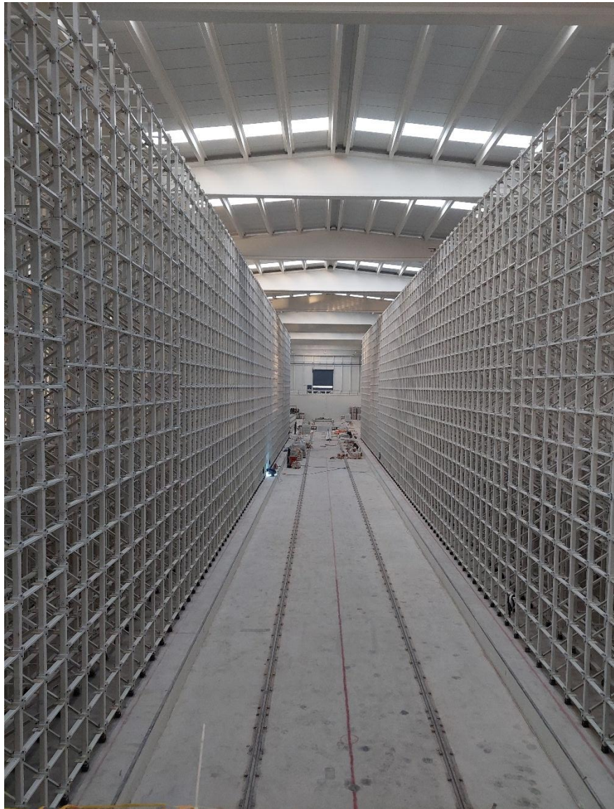
Εικόνα 1. Αποθήκη από μεταλλικά ράφια σε εργοστάσιο διέλασης αλουμινίου
