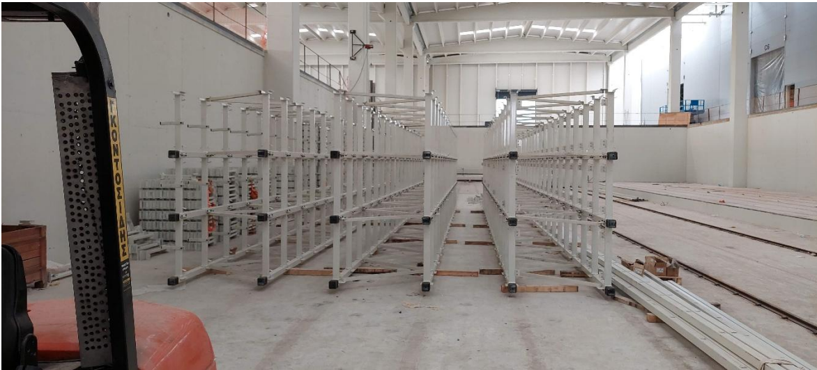
Εικόνα 2. Στάδιο συναρμολόγησης και ανέγερσης των ραφιών
