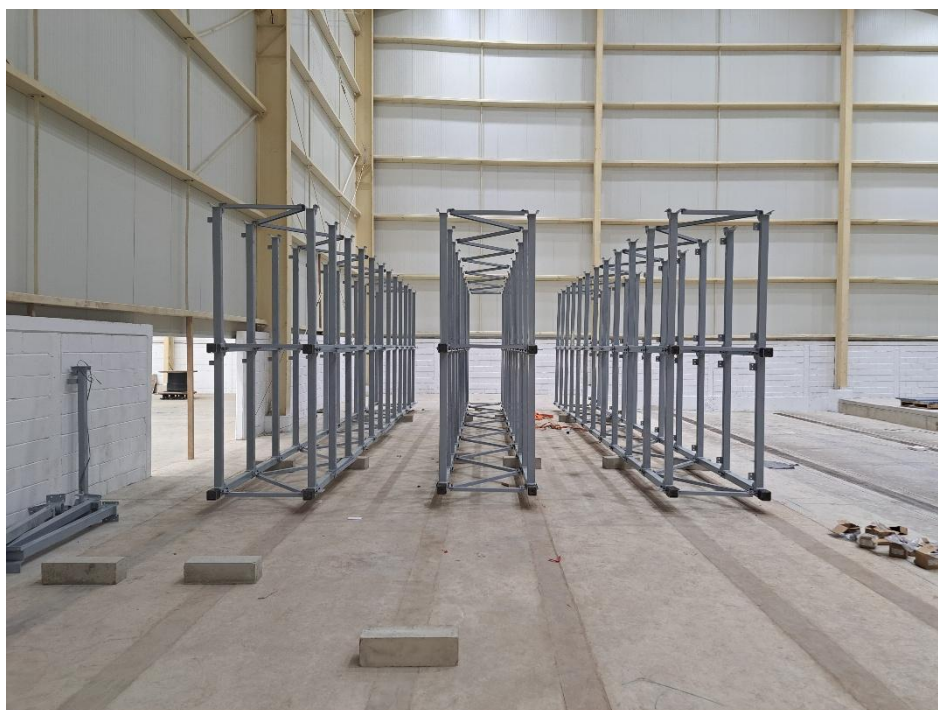
Εικόνα 4. Έργο 1. Συναρμολόγηση των πλαισίων.
