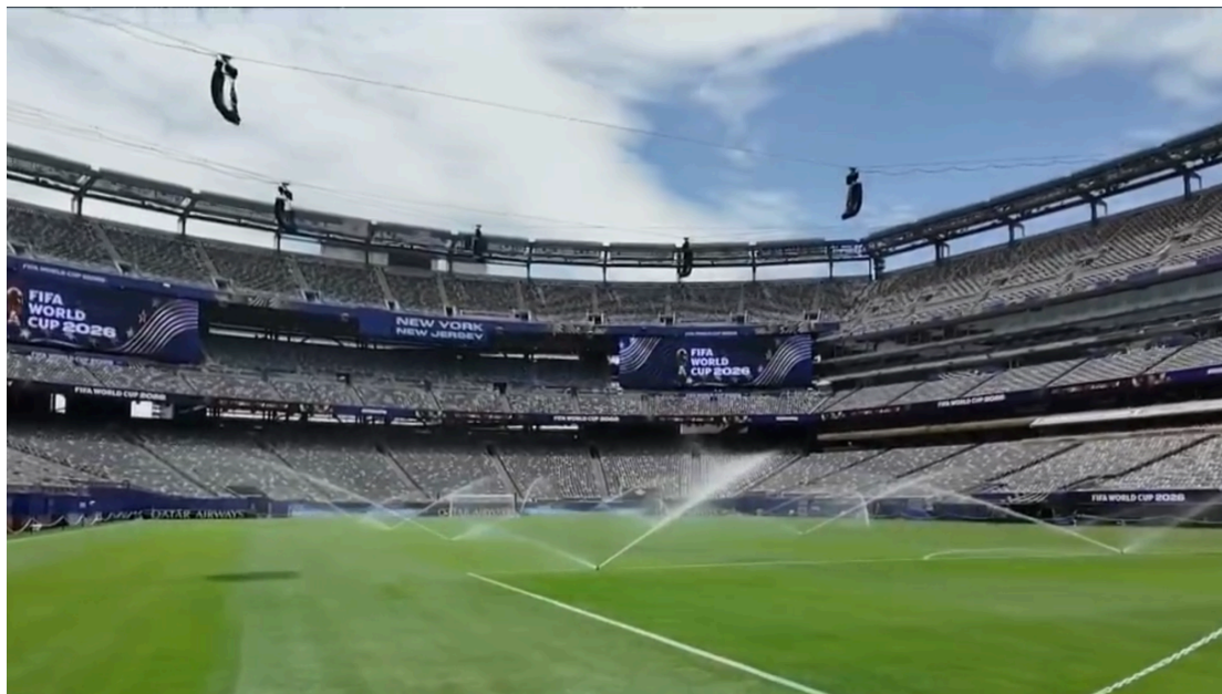
Εικ.4.9. Εφαρμογή μόνιμης ηλεκτρακουστικής εγκατάστασης σε στάδιο ποδοσφαίρου στο New Jersey, NY, με κρέμαση στην οροφή 25
