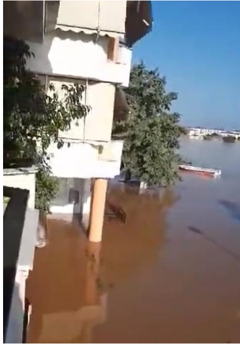
Εικόνα 32: Πλημμυρισμένη περιοχή Εργατικές Κατοικίες Γιάννουλης. Πηγή: Σίμου Γεωργία (2023)
