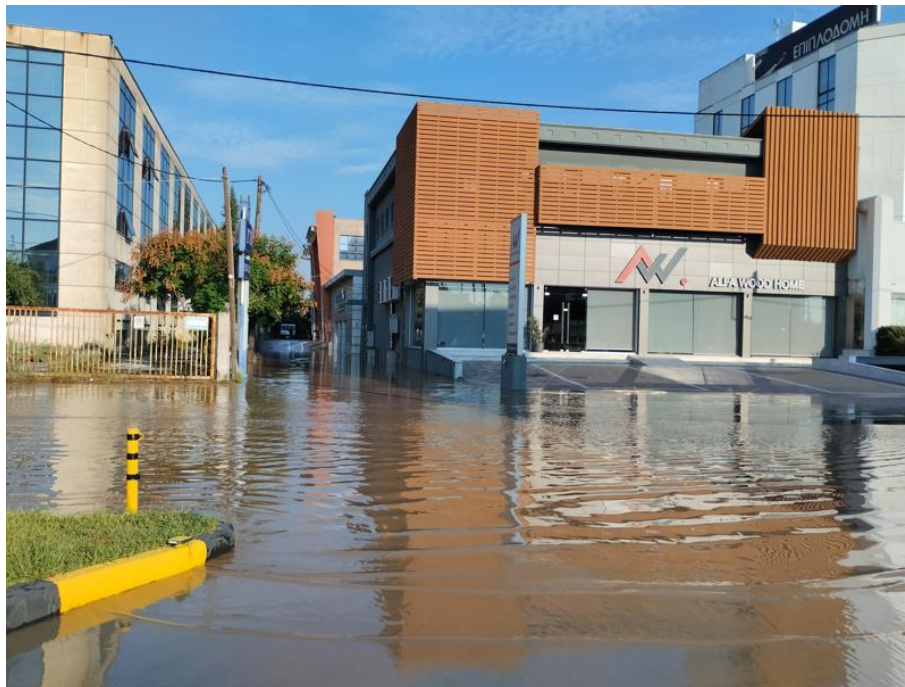
Εικόνα 21: Πλημμυρισμένος δρόμος οδός Σωκράτους, Ν. Σμύρνη. Πηγή: ίδια λήψη (2023)
