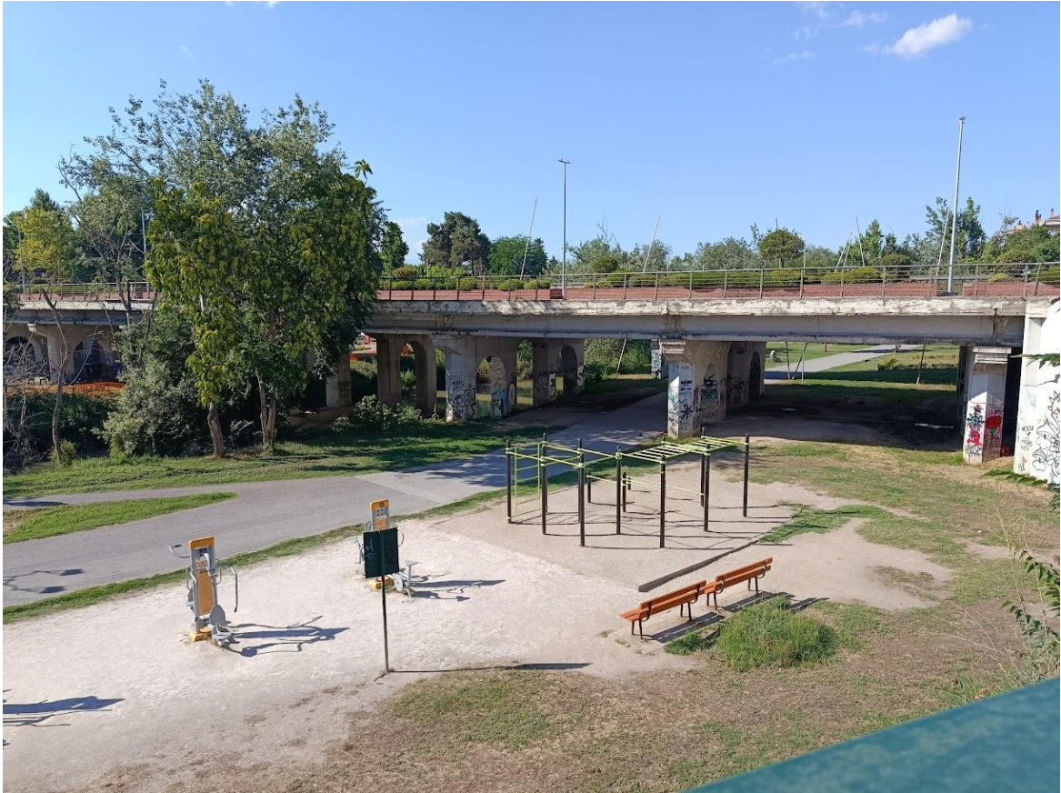
Εικόνα 34: Σημερινή εικόνα της γέφυρας Αλκαζάρ, του Πηνειού ποταμού και του περιβάλλοντα χώρου. (Πηγή: ίδια λήψη (2026))
