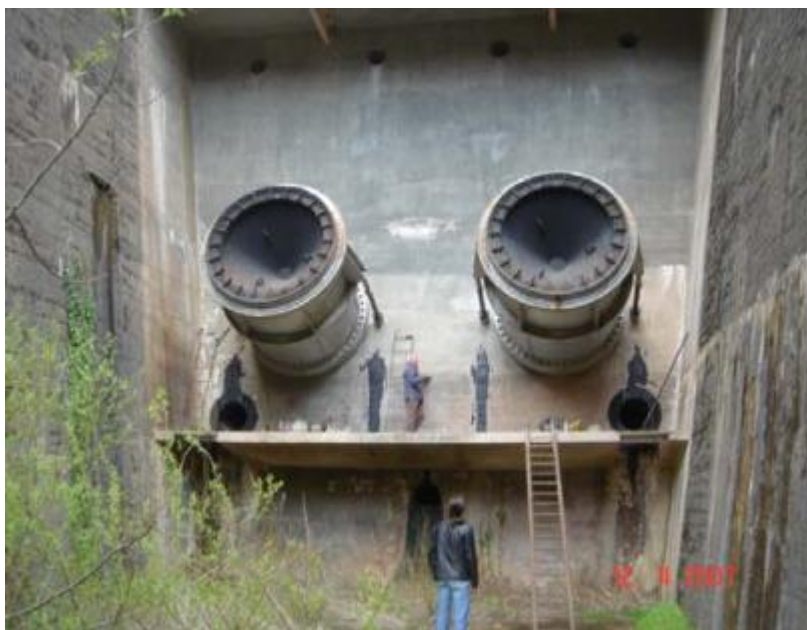
Οι δύο εκκενωτές του φράγματος Ταυρωπού, από κατάντη.
