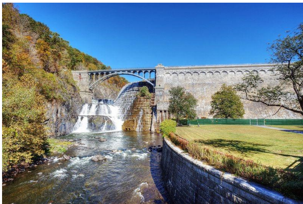
Εικόνα 1: Λιθόκτιστο φράγμα (New Croton Dam, ΗΠΑ)
