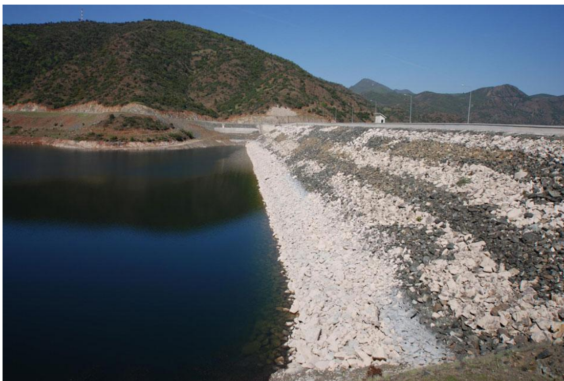
Εικόνα 1: Λιθόρριπτο φράγμα (Σμόκοβο)
