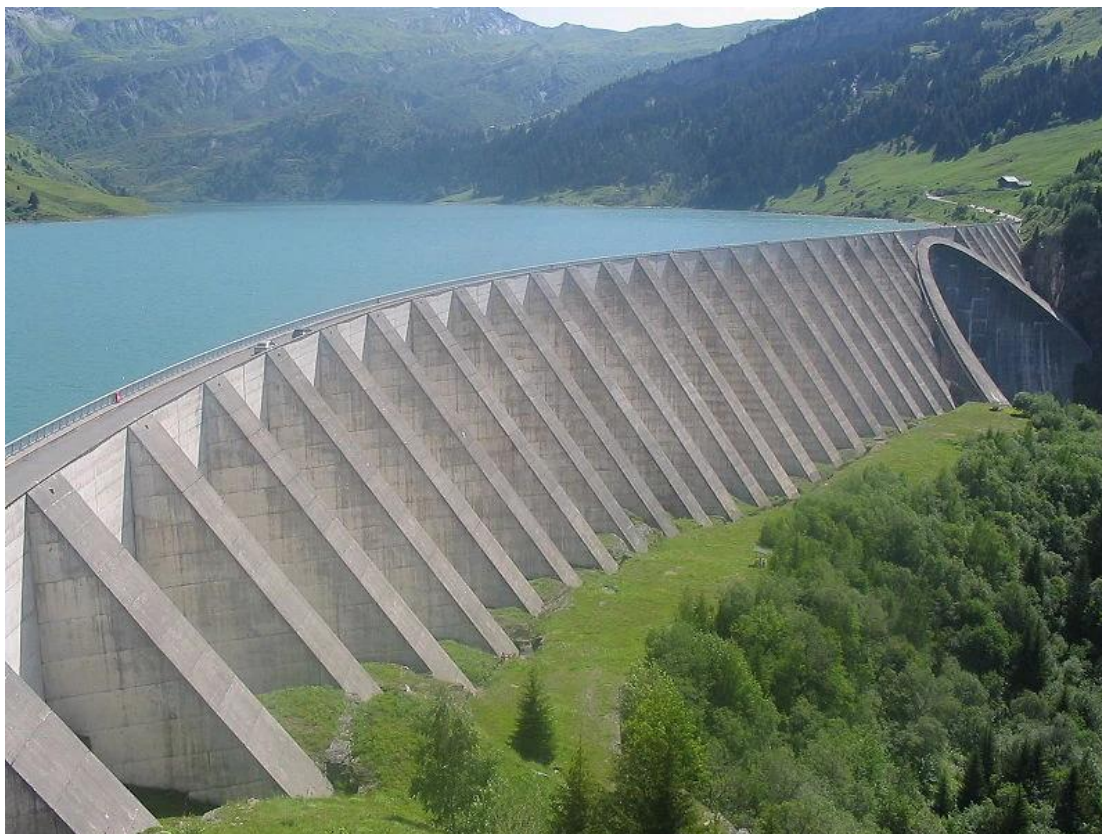
Εικόνα 1: Φράγμα πολλαπλών τόξων (Roselend Dam, Γαλλία)
