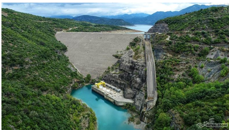
Εικόνα 1: Υδροηλεκτρικό φράγμα (Κρεμαστών, Αιτωλοακαρνανία)
