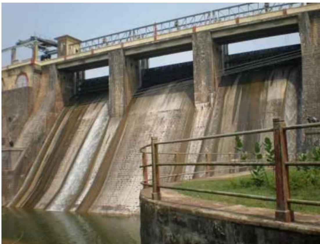
Υπερχειλιστής φράγματος τύπου S (Ogee Spillway)
