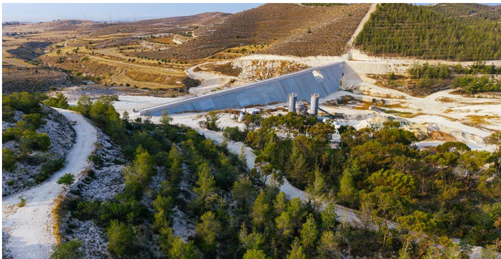
Εικόνα 1: Αντιπλημμυρικό φράγμα (Αραδίππου, Κύπρος)
