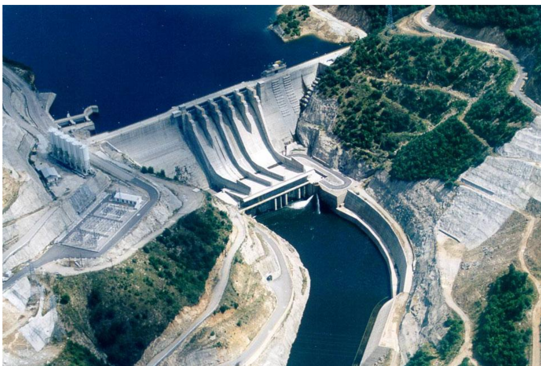
Εικόνα 2: Ευθύγραμμο φράγμα βαρύτητας από RCC (Πλατανόβρυση)
