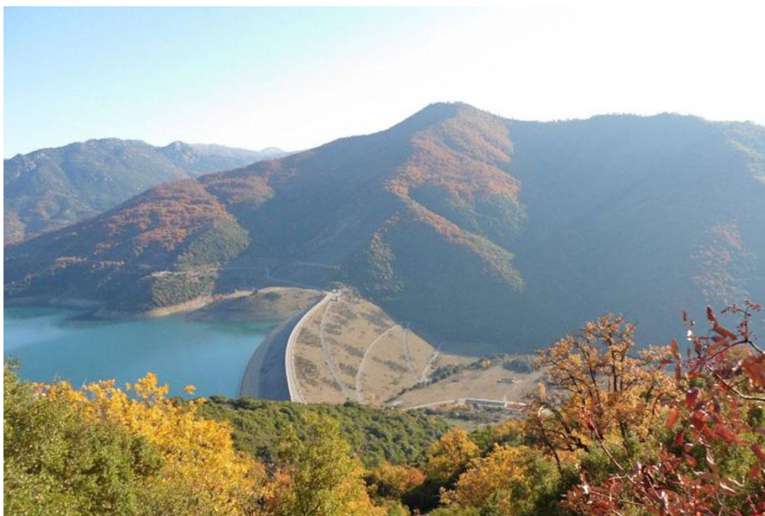
Εικόνα 2: Γαιώδες-Χωμάτινο φράγμα (Μόρνου)
