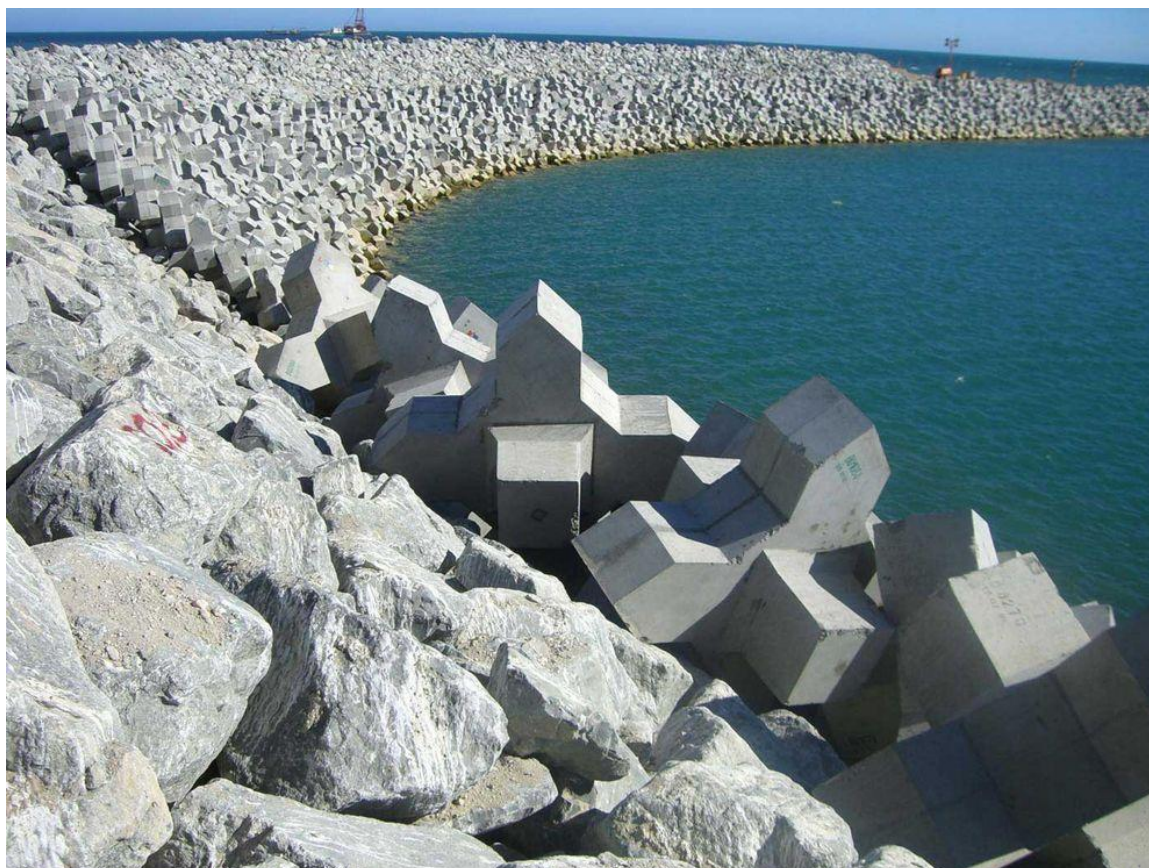
Εικόνα 5. Τεχνητοί ογκόλιθοι από σκυρόδεμα, τύπου Xbloc, στο πρηνές κυματοθραύστη (Λήψη από https://www.xbloc.com/our-blocks/xbloc ).
