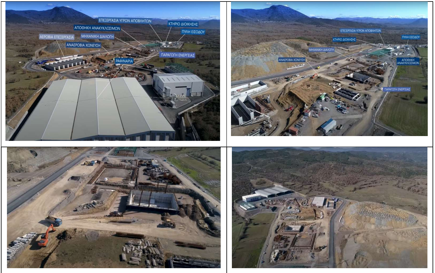
Εικόνες 4.3.2.5-17. Εικόνες από τη φάση κατασκευής του έργου. (Πηγή: ΤΕΡΝΑ ΕΝΕΡΓΕΙΑΚΗ)
