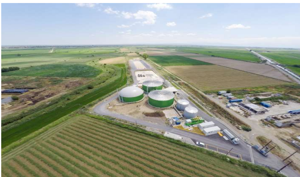
Εικόνα 4.3.2.1. Ολοκληρωμένη Διαχείριση Απορριμμάτων της Περιφέρειας Πελοποννήσου (Πηγή: ΤΕΡΝΑ ΕΝΕΡΓΕΙΑΚΗ)
