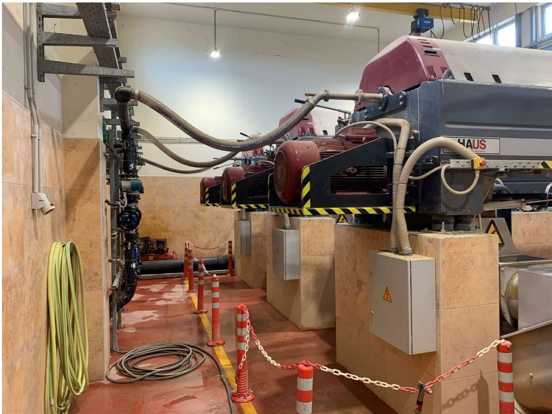
Εικόνα 7: Διάταξη βιομηχανικών φυγοκεντρικών διαχωριστών (decanters) αφυδάτωσης ιλύος.
