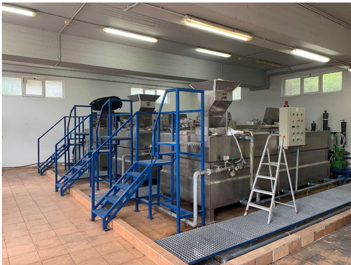
Εικόνα 3: Αντιπροσωπευτική διάταξη δεξαμενών παρασκευής με εξέδρες εργασίας και σκάλες πρόσβασης.
