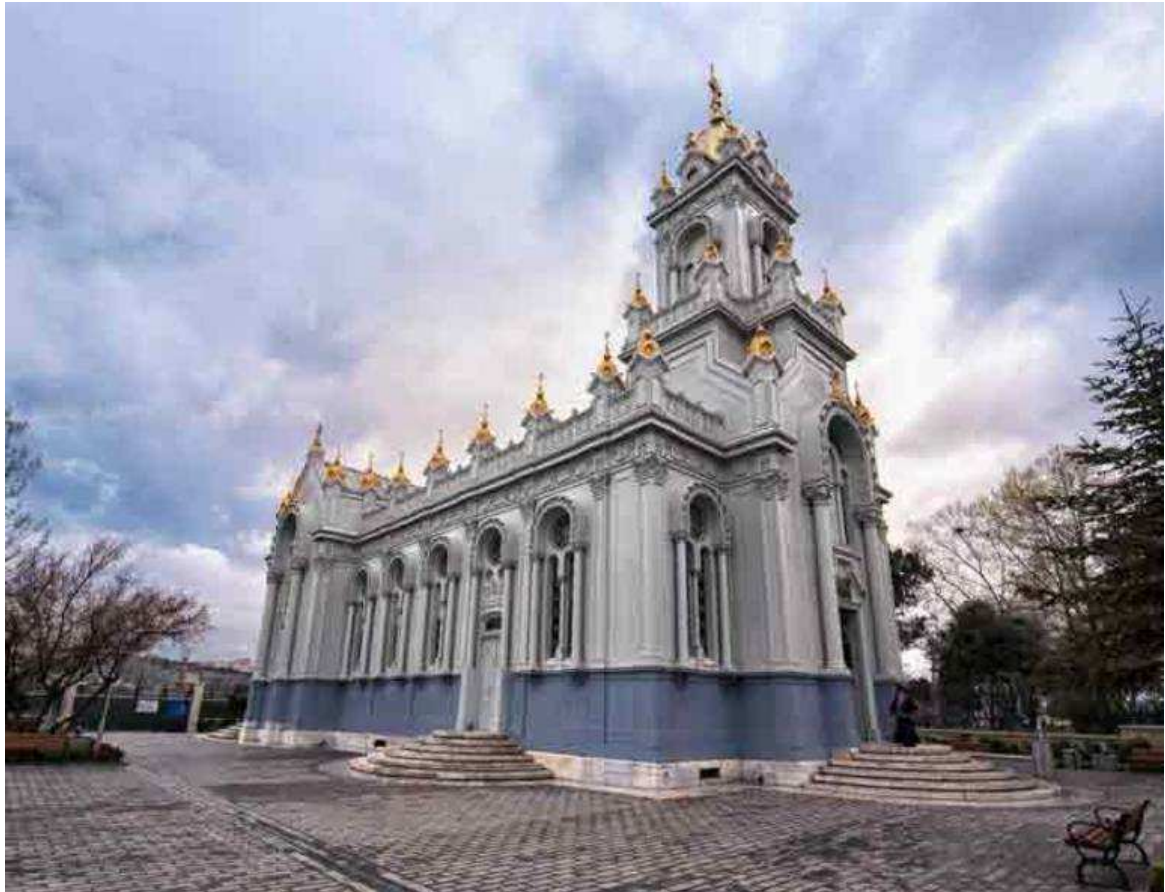
Εικόνα 6: Ο Ναός του Αγίου Στεφάνου στην συνοικία Φανάρι στην Κωνσταντινούπολη. Επονομαζόμενος και ως " Βουλγάρικος". Ιδιαιτερότητα του είναι ότι είναι εξ' ολοκλήρου κατασκευασμένος από σίδηρο, μοναδικός στο είδος του. (πηγή:ιστοτοπος, ecclesia.gr)
