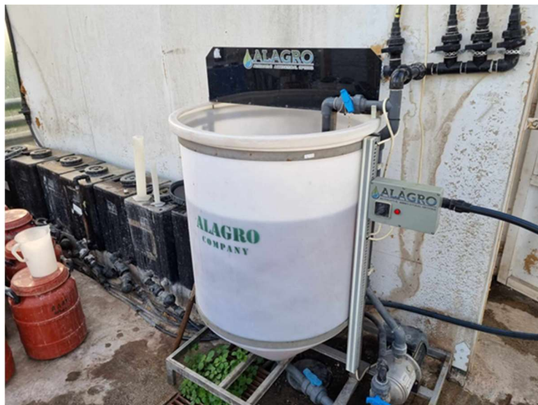
Εικόνα 16: Δεξαμενή 300lt για την ανάμιξη των μητρικών διαλυμάτων
