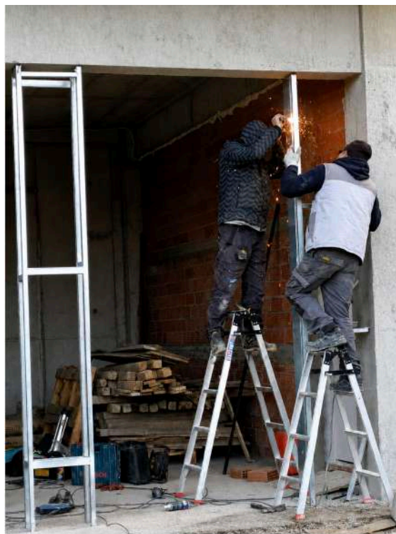
Σχήμα 5.7: Συγκόλληση ψευτοκασών.
