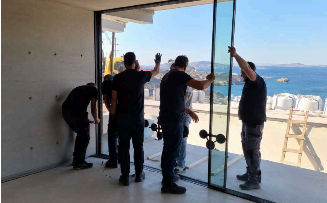
Σχήμα 5.5: Συνεργείο τοποθέτησης κατά την εγκατάσταση των συστημάτων.
