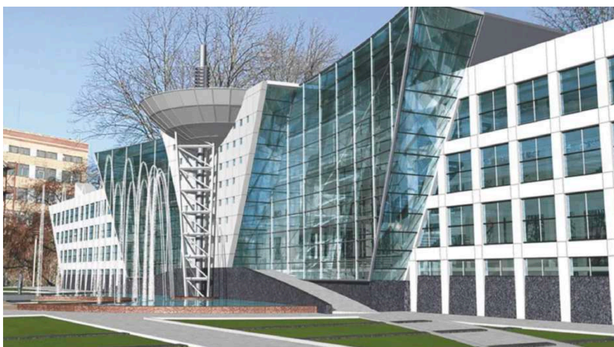
Σχήμα 2.6: Σύστημα υαλοπετάσματος με διάταξη ορθοστατών και τραβερσών.
