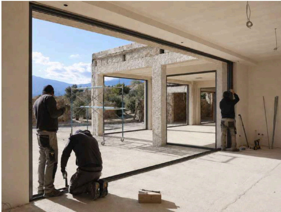
Σχήμα 4.31: Τοποθέτηση περιμετρικών κασωμάτων.
