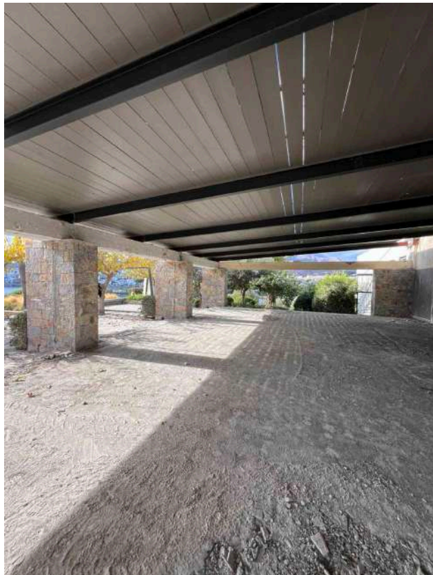
Σχήμα 4.2: Πραγματική κατάσταση του χώρου πριν την εγκατάσταση των κουφωμάτων.
