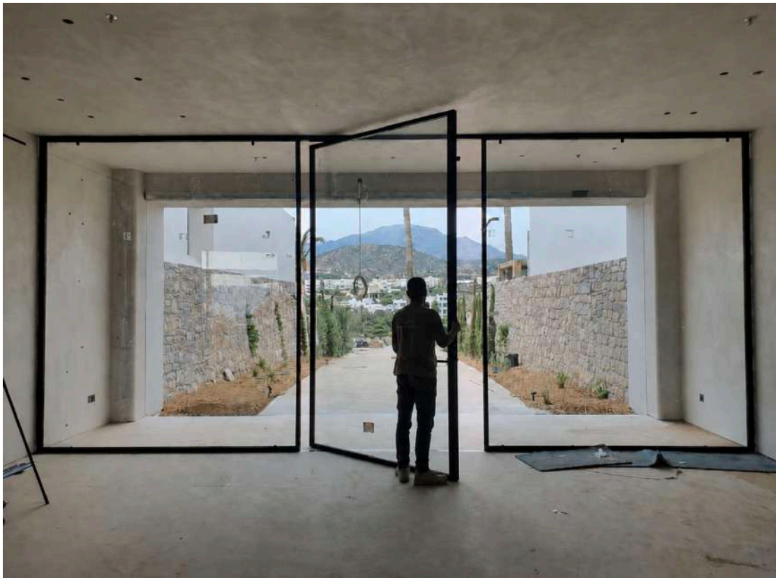
Σχήμα 4.34: Έλεγχος λειτουργίας σύνθεσης κουφώματος Pivot, θέση 2-3
