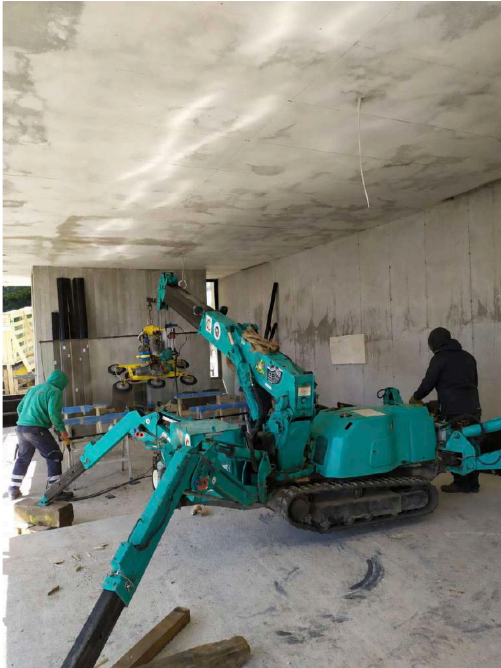
Σχήμα 4.33: Τοποθέτηση φύλλων με χρήση ρομποτικού τύπου αράχνης μηχανήματος.
