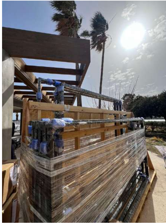
Σχήμα 4.30: Παραλαβή κουφωμάτων και υαλοπινάκων στο εργοτάξιο.
