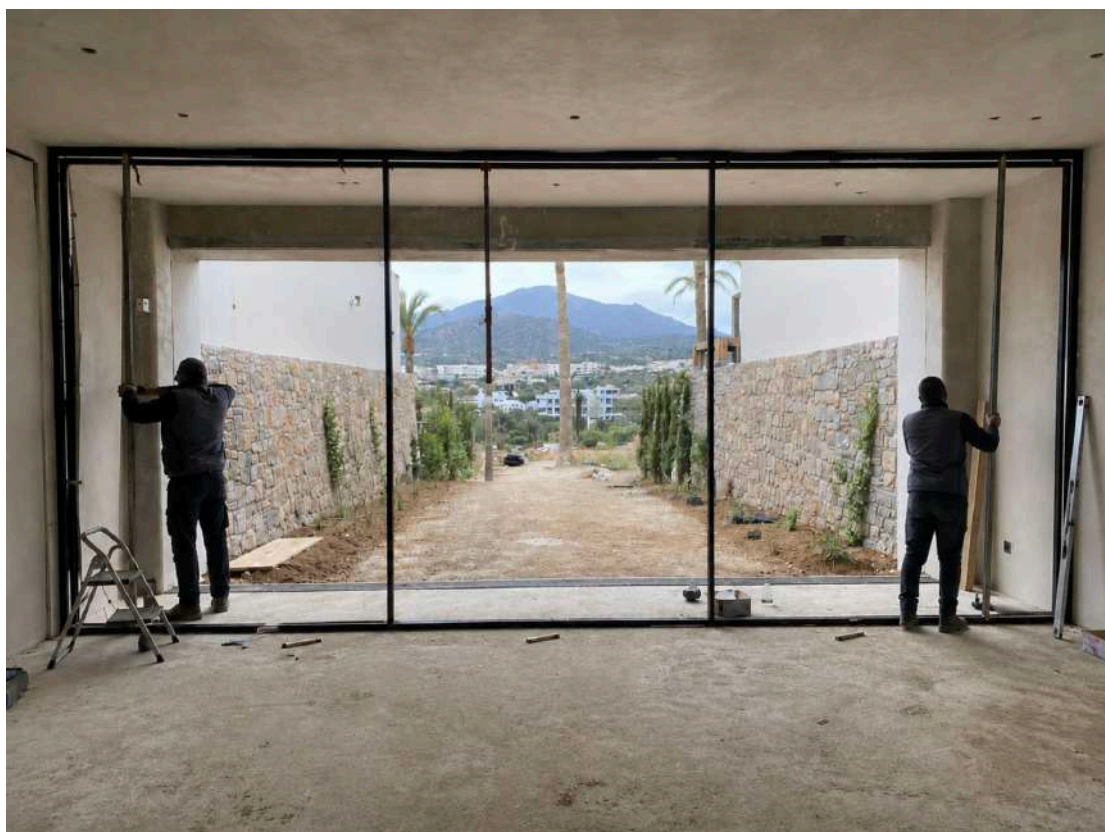
Σχήμα 4.32: Τοποθέτηση πινot κατασκευής, θέση 2-3
