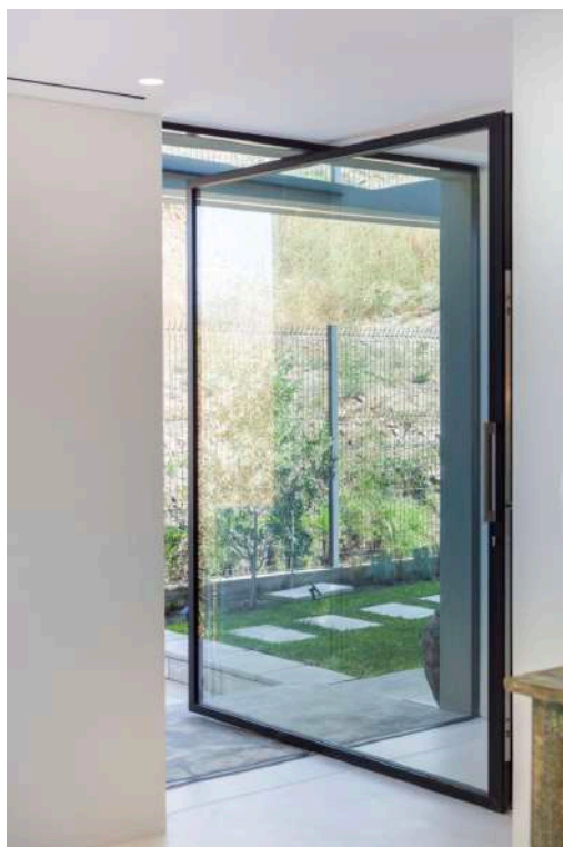
Σχήμα 2.4: Pivot κούφωμα με κεντρικό άξονα περιστροφής.
