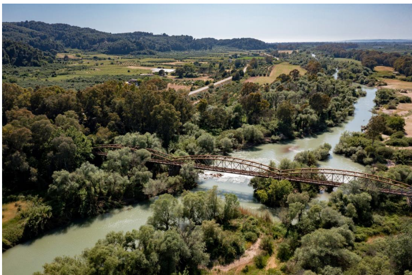
Εικόνα 24. Γέφυρα του Αλφειού. Πηγή: https://www.visit-olympia.gr/listing/sidirodromiki-gefyra-alfeiou
