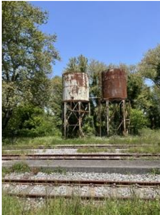
Εικόνα 26. Υδατόπυργοι σταθμού «Λεύκτρον». Πηγή: Ιδία λήψη
