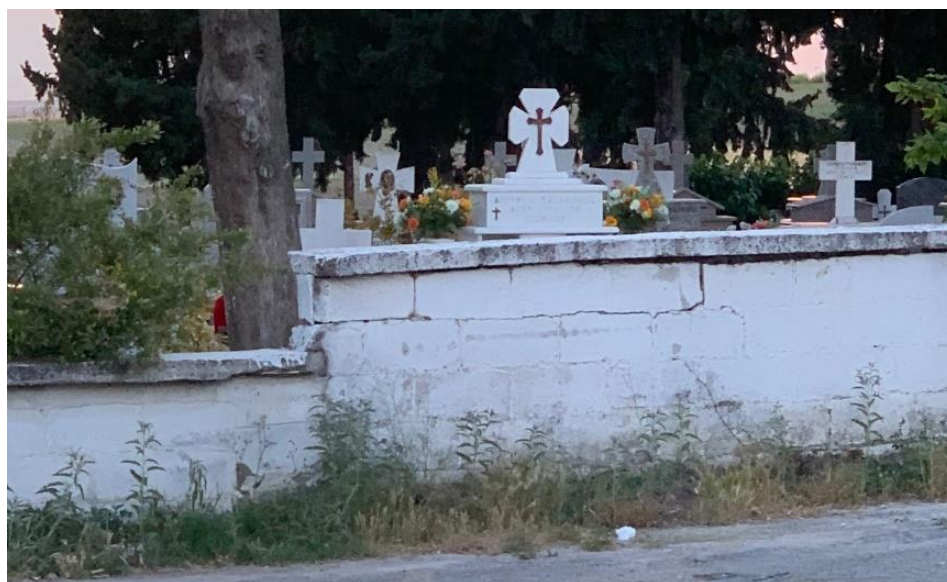
Εικόνα 57 - Ρωγμές σε τοιχοποιία περίφραξης (προσωπικό αρχείο)
