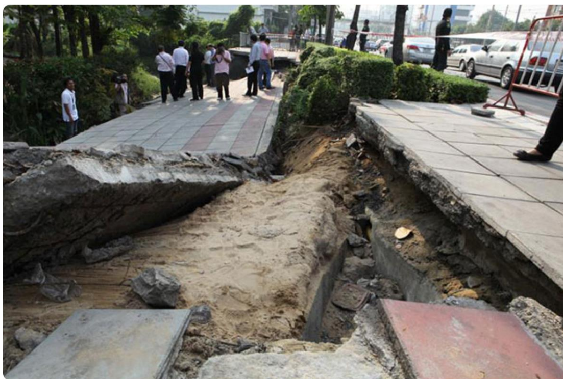
Εικόνα 25 - Κατάρρευση πεζοδρομίου από εδαφική υποχώρηση σε αστικό περιβάλλον (Reporters O., 2015)
