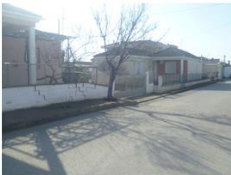
Εικόνα 18 - Εδαφικές διαρρήξεις στο οδόστρωμα και ρωγμές στην τοιχοποιία περίφραξης στον οικισμό της Χάλκης (Κεραμοπούλου Β., 2014)
