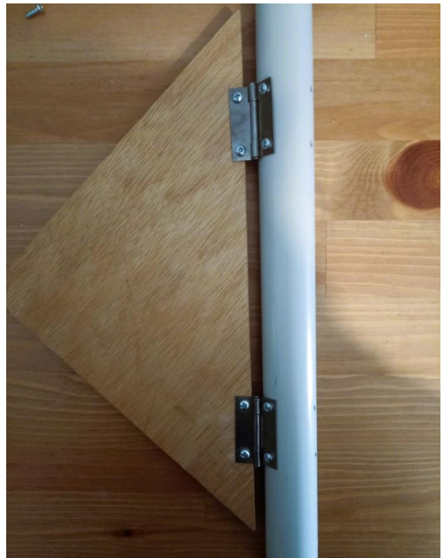
Εικόνα 99. Τρύπημα και βίδωμα των μεντεσέδων στον άξονα κίνησης – διαγώνιο PVC.
