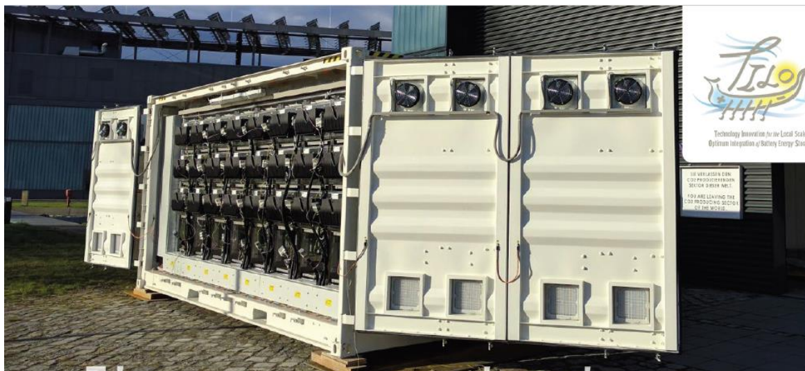
Σχήμα 48: TILOS - Σύστημα συσσωρευτών ενέργειας ( www.tiloshorizon.eu )
