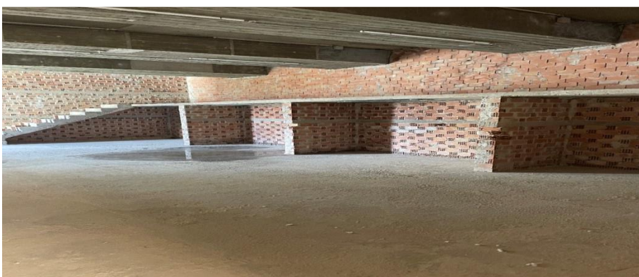
Εικόνα 16.: Χώρος Β' ορόφου
