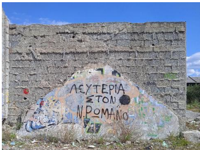
Εικόνα 43 Σύνθεση από φωτογραφίες από πολιτικά graffiti και συνθήματα, στο εργοστάσιο της Βαμβακουργίας στον Βόλο. Πηγή: Προσωπικό αρχείο
