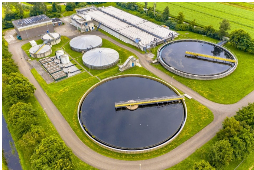
Εικόνα 3: Μονάδα επεξεργασίας υγρών αποβλήτων (Globalex, n.d.)
