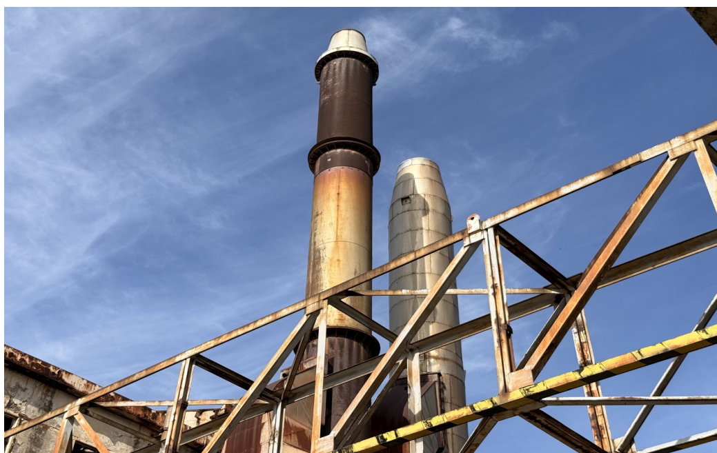
Εικόνα 3-6: Σημερινή εικόνα των καμινάδων του μηχανοστασίου της Πειραικής- Πατραϊκής. (Φωτ. Βασιλική Δρακούλη, 30 Οκτωβρίου 2025).
