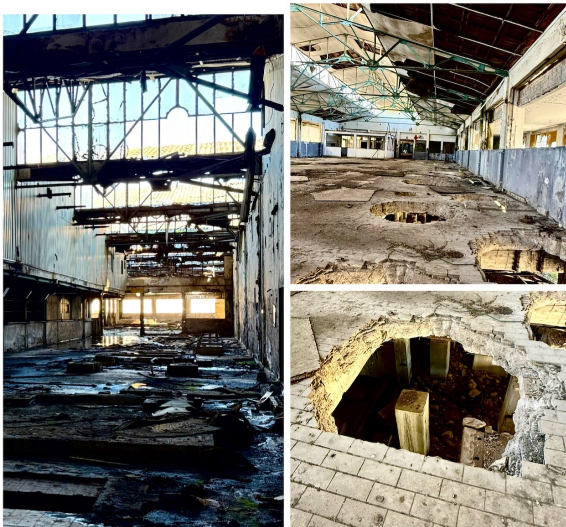
Εικόνα 4-7: Σημερινή εικόνα πρώην τμημάτων παραγωγής του εργοστασίου και τα κτιριακά «σημάδια» ύστερα από την απομάκρυνση των μηχανών (Φωτ. Βασιλική Δρακούλη, 6 Νοεμβρίου 2025)
