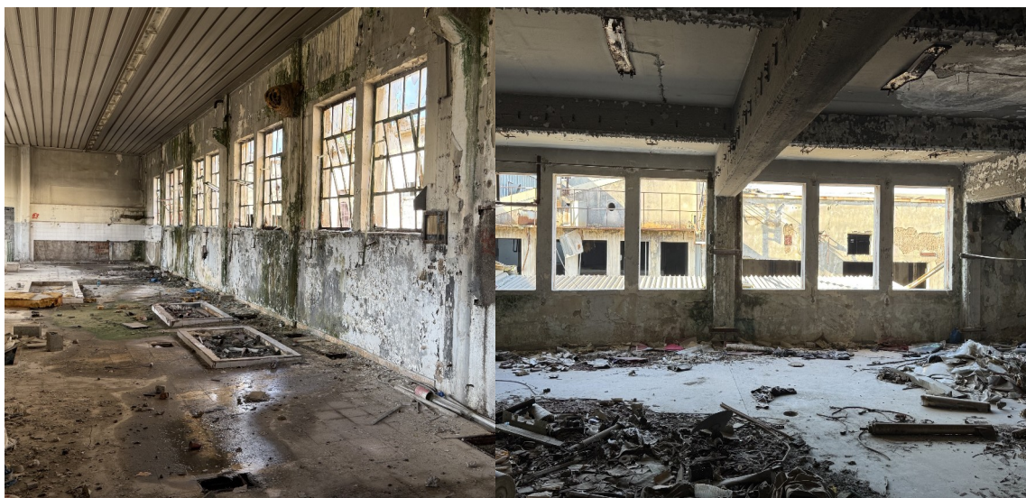
Εικόνα 3-8: Παράθυρα για φυσικό φωτισμό είχε μεταξύ άλλων το χημείο (δεξιά) και το σχεδιαστήριο (αριστερά). (Φωτ. Βασιλική Δρακούλη, 30 Οκτωβρίου 2025).
