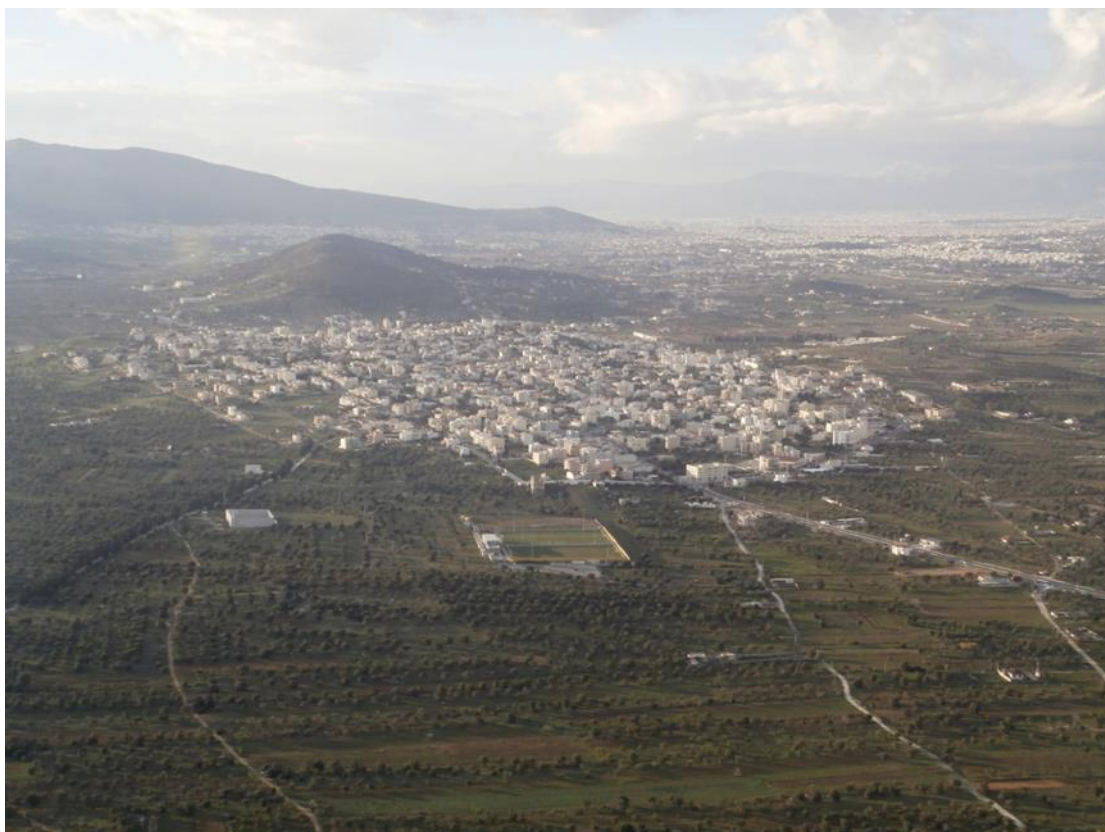
Εικόνα 5: Αεροφωτογραφία και γεωγραφική αποτύπωση της ευρύτερης περιοχής των Σπάτων και της πεδιάδας των Μεσογείων, όπου αποτυπώνεται η γειτνίαση με τον Διεθνή Αερολιμένα Αθηνών και η χωρική ανάπτυξη της περιοχής.
