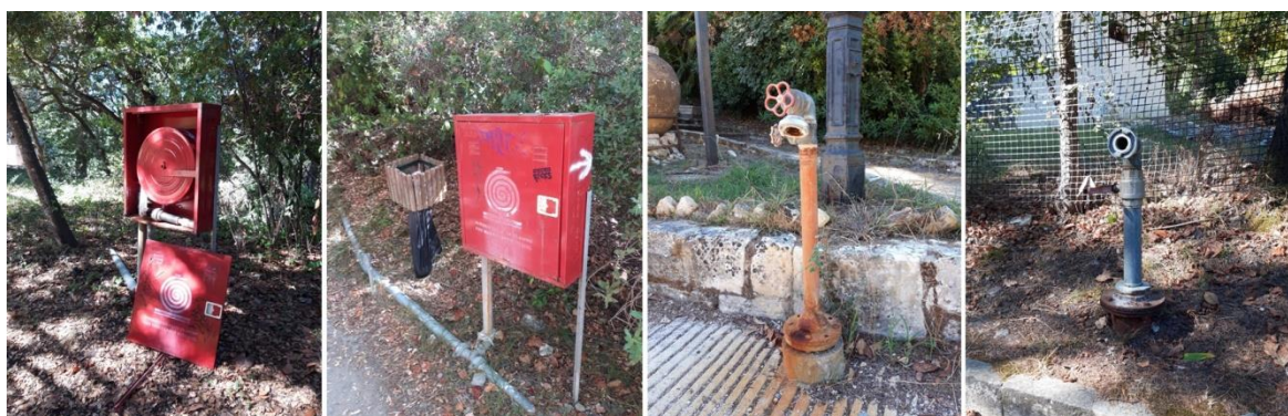
Εικόνα 141. Κρουνοί και πυροσβεστικές φωλιές με ανέμη σε διάφορα σημεία του πάρκου (Πηγή: προσωπικό αρχείο, 2022).
