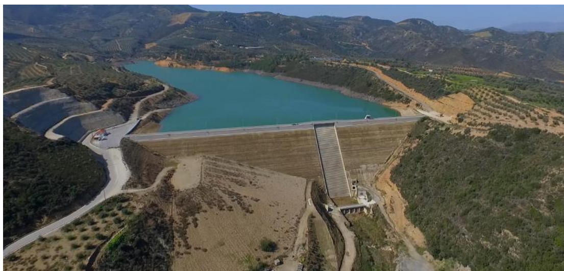
Εικόνα 1. Το φράγμα Βαλσαμιώτη στα Χανια (Πηγή: https://www.ertnews.gr/perifereiakoi-stathmoi/chania/techniki-syskepsi-ston-o-a-k-gia-to-fragma-valsamioti/ )
