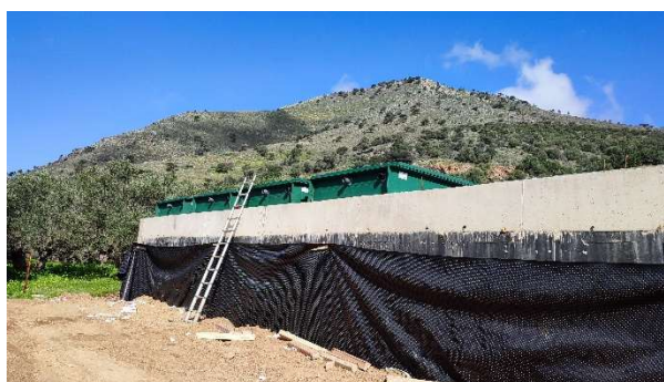
Εικόνα 3.3: Εφαρμογή μεμβράνης πολυαιθυλενίου (αυγουλιέρα)
