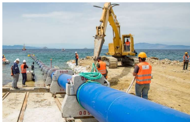
Εικόνα 6.2: Προετοιμασίας/πόντισης συγκολλημένων τμημάτων HDPE για υποθαλάσσια εφαρμογή
