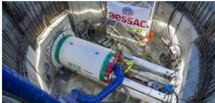
Εικόνα 6.3: Τοποθέτηση προκατασκευασμένου σωλήνα σκυροδέματος χαμηλού άνθρακα. ( https://www.vinci.com/newsroom/actualites/premiere-mondiale-vinci-construction-construit-le-premier-tunnel-realise )
