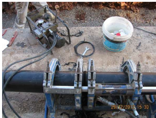
Εικόνα 4.3: Διαδικασία μετωπικής συγκόλλησης ευθύγραμμων τμημάτων HDPE
