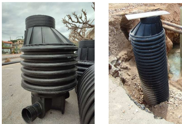
Εικόνα 3.1-3.2 : Προκατασκευασμένα φρεάτια επίσκεψης από πολυαιθυλένιο
