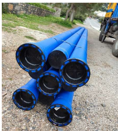
Εικόνα 4.4: Σωλήνες Όλκιμου Χυτοσιδήρου
