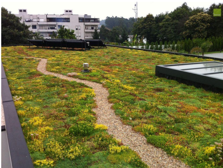
Εικόνα 39. Φυτεμένο δώμα εκτατικού τύπου ( πηγή : https://efb-greenroof.eu/work/extensive-green-roof-portugal/ ).
