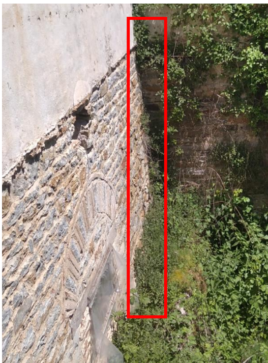
Εικόνα 23 Άποψη του αρμού στη στάθμη ισογείου και στη συμβολή της ΒΑ λιθοδομής του τμήματος Α και της ΒΑ όμοιας του τμήματος Β
