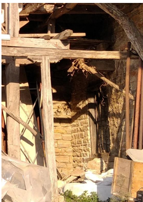
Φωτογραφία 9. Συμβολή λιθοδομών Τμήματος Α και Τμήματος Β στο 1 ο επίπεδο
