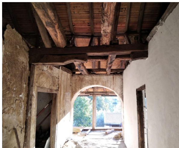
Φωτογραφία 4. Τμήμα Α – λιθοδομή με ξύλινα διαζώματα και θύρα αριστερά και τοξωτό άνοιγμα στην ΝΔ πρόσοψη δεξιά
