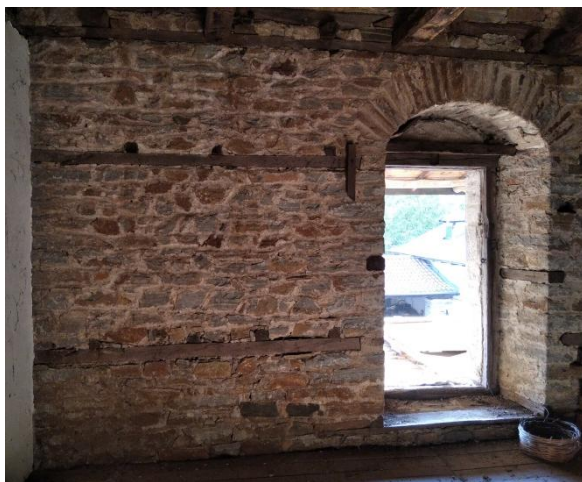
Φωτογραφία 4. Τμήμα Α – λιθοδομή με ξύλινα διαζώματα και θύρα αριστερά και τοξωτό άνοιγμα στην ΝΔ πρόσοψη δεξιά
