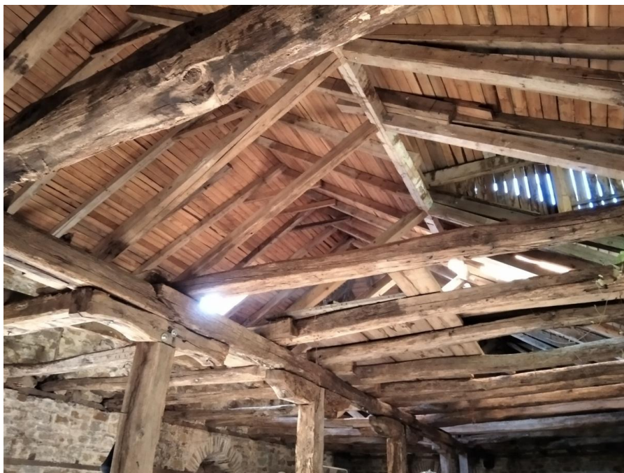
Εικόνα 13 Άποψη της δομής της στέγης στο 2 ο επίπεδο του τμήματος Α
