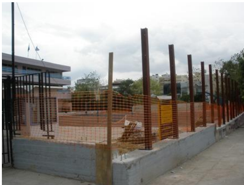
Εικόνα 6-2 Τοποθέτηση ηχοπετάσματος στο 1ο Γυμνάσιο Αγίων Αναργύρων
