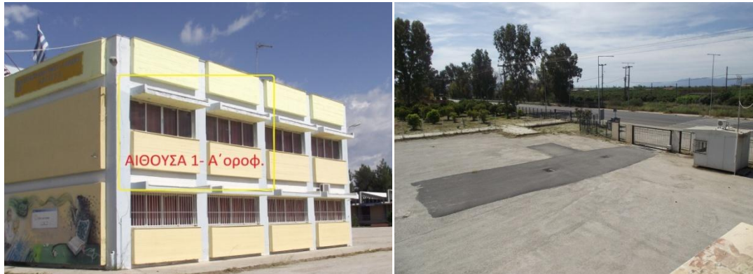
Εικόνα 4-2 Αίθουσα 1 – α΄ όροφος (εξωτερική όψη και οπτική προς την αρτηρία)
