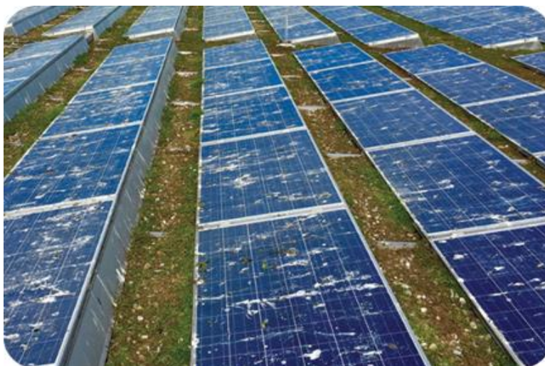
Σχήμα 3. Ακαθαρσίες πουλιών σε φωτοβολταϊκό πάρκο (Bird Control Group, 2018)
