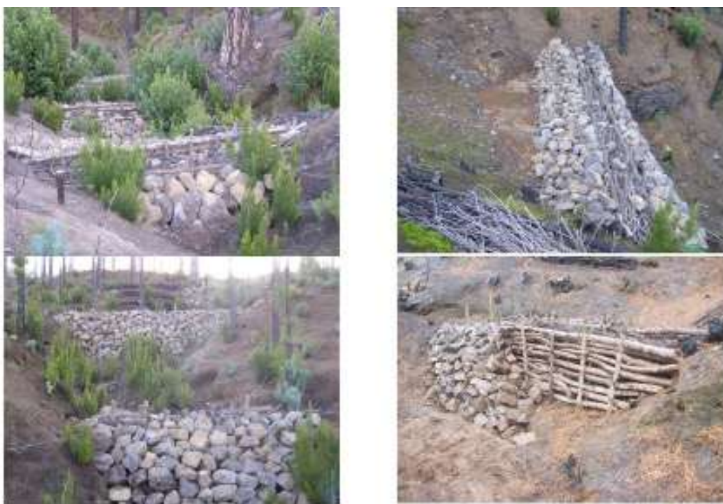
Εικόνα 6. Μικρά φράγματα ανάσχεσης από πέτρα και ξύλο (Πηγή: WaterPIP, Ιστότοπος: http://www.waterproductivity.org/product/check-dams/ )
