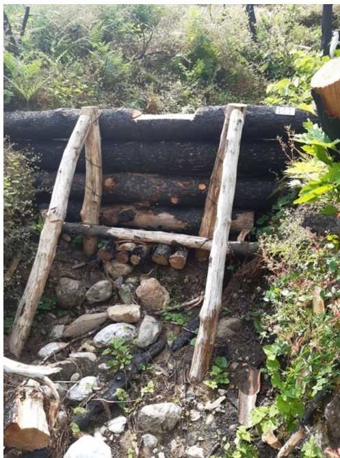
Εικόνα 38. Κορμοφράγματα μετά τις κακοκαιρίες του 2023 (Πηγή: Δασαρχείο Ιστιαίας)
