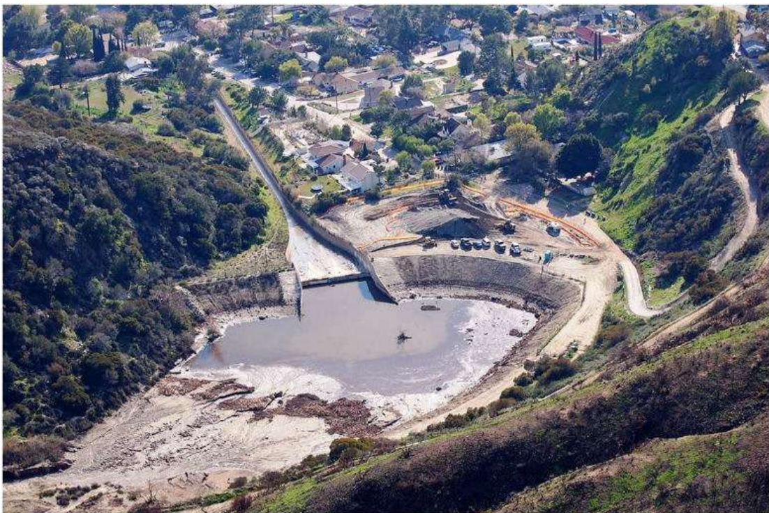
Εικόνα 45. Debris Basin (Πηγή: Public Works- lacounty)
