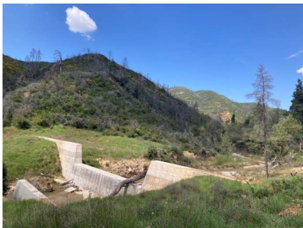
Εικόνα 37 Φράγματα βάρους μετά τις κακοκαιρίες του 2023 (Πηγή: Δασαρχείο Ιστιαίας)
