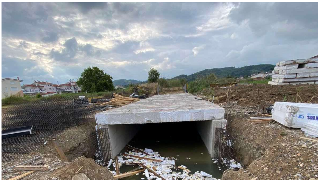
Εικόνα 34. Υπό κατασκευή πλακοσκεπής αγωγός (ίδια πηγή)
