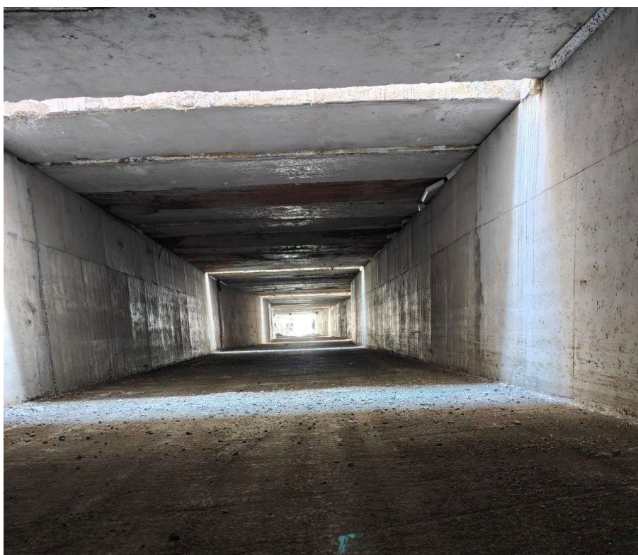
Εικόνα 28. Εσωτερικό πλακοσκεπούς αγωγού στο Μαντούδι (Πηγή: ίδια πηγή)
