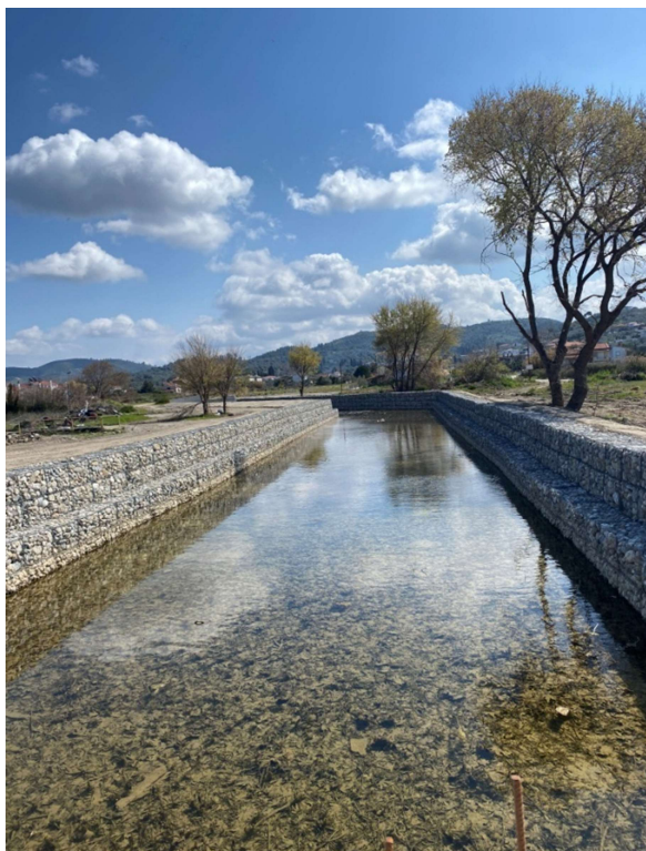
Εικόνα 30. Διατομή τύπου ανεστραμμένου "Π" από συρματοκιβώτια (Πηγή: ίδια επεξεργασία)
