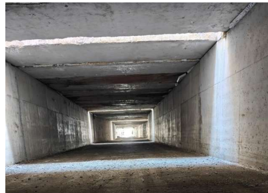
Εικόνα 7. Εσωτερικό πλακοσκεπούς αγωγού στο Μαντούδι (Πηγή: ίδια πηγή)
