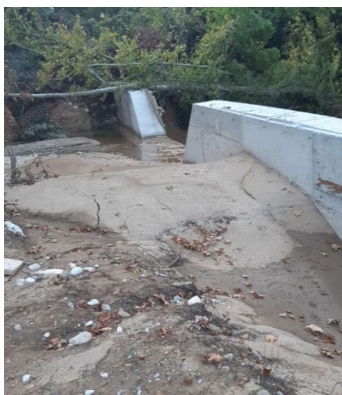
Εικόνα 37 Φράγματα βάρους μετά τις κακοκαιρίες του 2023 (Πηγή: Δασαρχείο Ιστιαίας)
