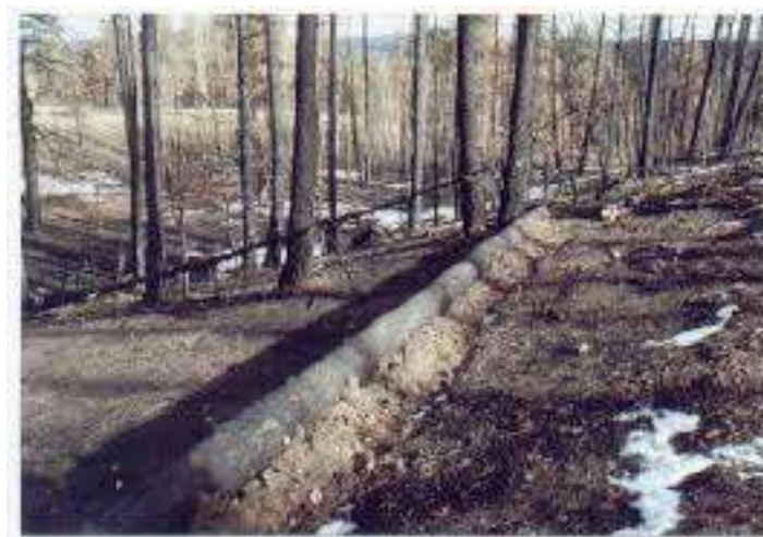
Εικόνα 4. Log barriers (Πηγή: USDA NRCS 2012 Fact Sheet, Ιστότοπος: https://co-co.org/wp-content/uploads/2018/07/2012-Log-erosion-barrier-Fact-Sheet.pdf )
