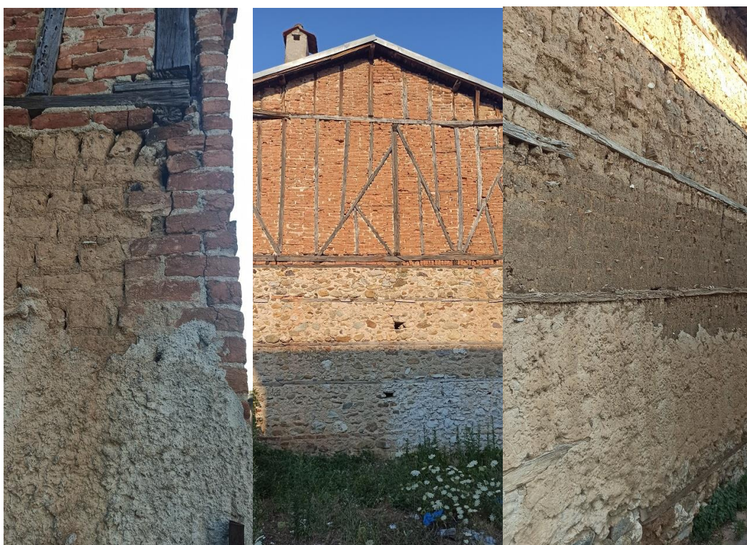
Εικόνα 12: ενδεικτική απεικόνιση υλικών και τρόπου ανοικοδομήσεως των κατοικιών του οικισμού με πέτρα, ξυλοδεσιές, συμπαγείς πλίνθους και στέγη. Προσωπικό αρχείο Χ. Λαζαρίδη
