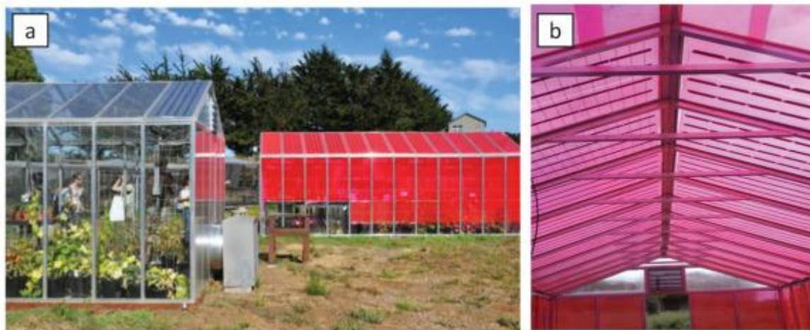
Εικόνα 16. α) Ένα θερμοκήπιο καλυμμένο με διαφανές γυαλί (αριστερά) και ένα θερμοκήπιο καλυμμένο με WSPV (δεξιά), (πηγή: Corrado et al., 2013), β) Εσωτερική όψη θερμοκηπίου που είναι καλυμμένο με WSPV (πηγή: Loik et al., 2017).
