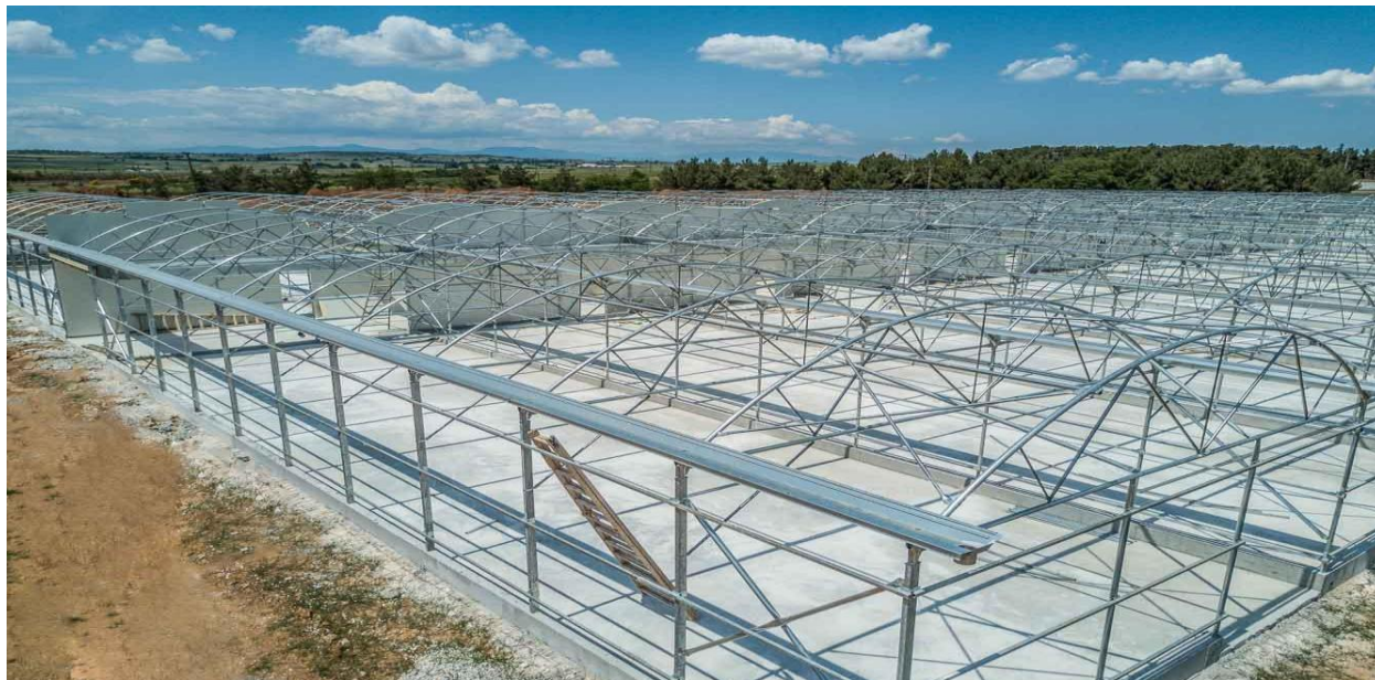
Εικόνα 6. Χάλυβας σε μορφή σωλήνα (σκελετός θερμοκηπίου). (πηγή: ekadem.gr).
